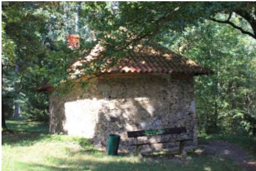
Obr. 28 - Zachovaný hraniční dům, tzv. Wachhaus. Nachází se v severní části vybraného území.
