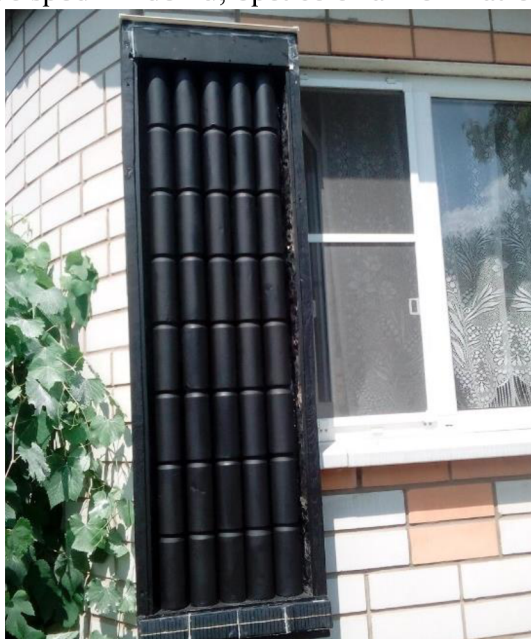
Obrázek 7: Vzduchový kolektor domácí výroby [20].
