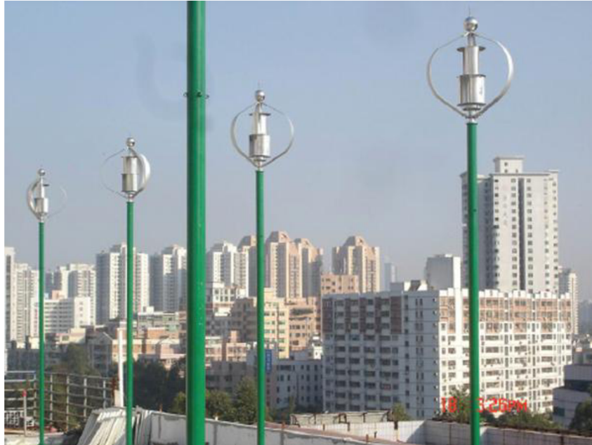
Obr.3.3 Instalace kombinovaného rotoru pro veřejné osvětlení čínském Shenzhen [13]
