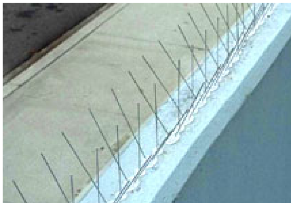
Obr. 19 Drôty zabráňujúce prístupu vtákov. Zdroj: birdbusters.com
