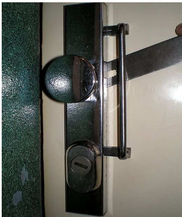
Příloha 83 - Pracovní postup při vytahování zubaté planžety
