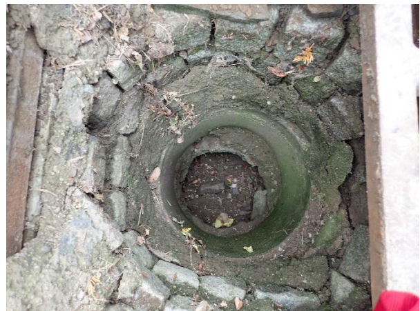
Obr. 49 Kanalizační šachta Š8 (vnitřek) [zdroj foto: V. Shamko]
