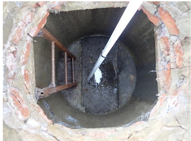
Obr. 47 Kanalizační šachta Š7 (vnitřek) [zdroj foto: V. Shamko]
