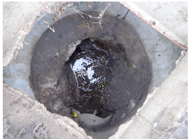
Obr. 55 Kanalizační šachta Š14 (vnitřek) [zdroj foto: V. Shamko]
