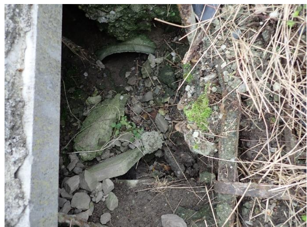
Obr. 51 Kanalizační šachta Š9 (vnitřek) [zdroj foto: V. Shamko]
