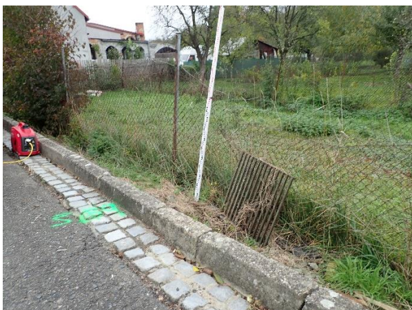
Obr. 50 Kanalizační šachta Š9 (lokalizace) [zdroj foto: V. Shamko]
