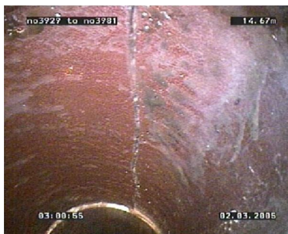
Obr. 13 Podélná trhлина [33]
