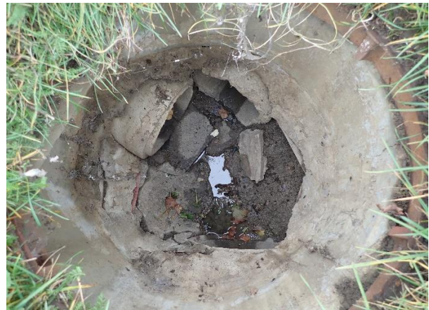
Obr. 53 Kanalizační šachta Š11 (vnitřek) [zdroj foto: V. Shamko]
