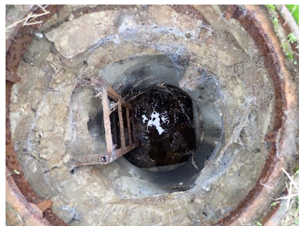
Obr. 45 Kanalizační šachta Š3 (vnitřek) [zdroj foto: V. Shamko]
