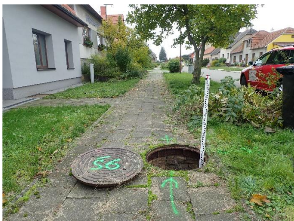
Obr. 44 Kanalizační šachta Š3 (lokalizace) [zdroj foto: V. Shamko]
