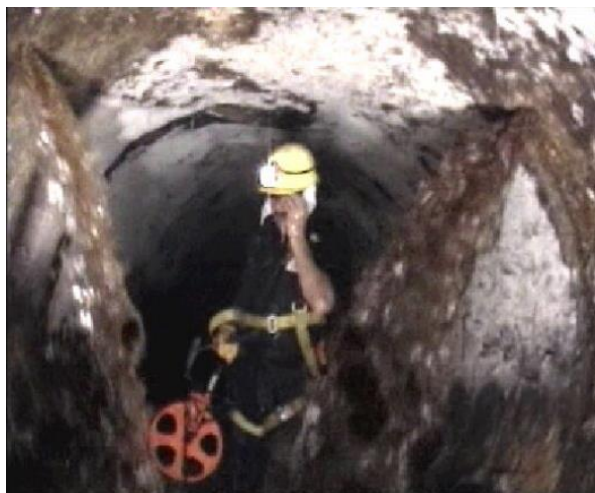
Obr. 18 Vizuální kontrola kmenové stoky ve městě Auckland [33]
