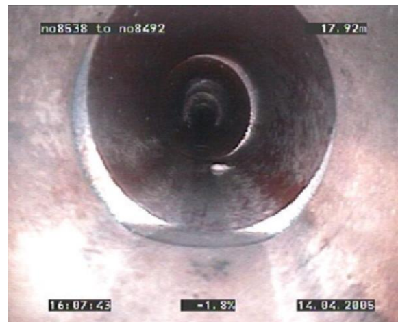
Obr. 11 Vertikální polohová odchylka potrubí [33]
