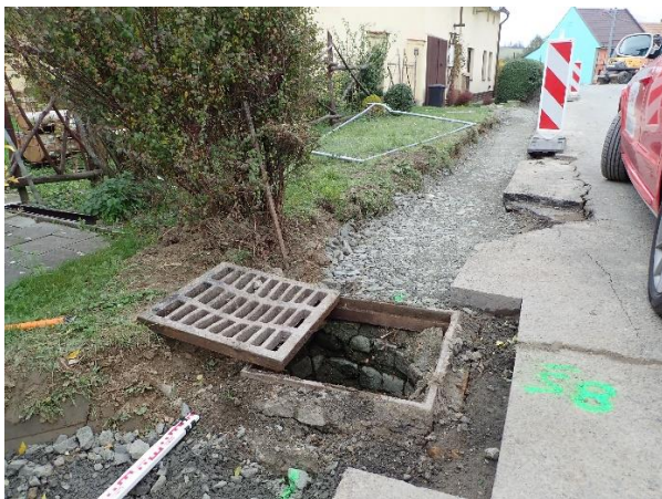
Obr. 48 Kanalizační šachta Š8 (lokalizace) [zdroj foto: V. Shamko]
