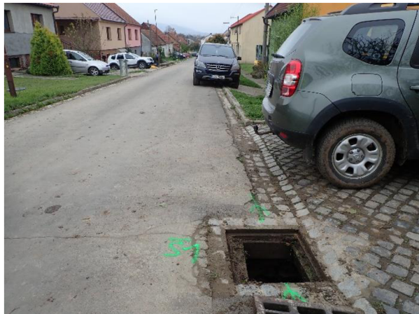
Obr. 42 Kanalizační šachta Š1 (lokalizace) [zdroj foto: V. Shamko]
