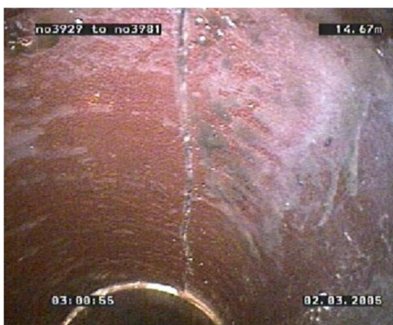
Obr. 13 Podélná trhлина [33]
