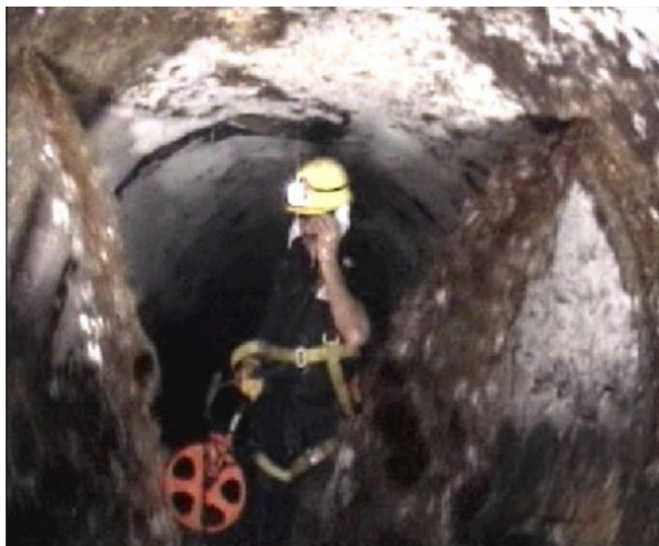
Obr. 18 Vizuální kontrola kmenové stoky ve městě Auckland [33]
