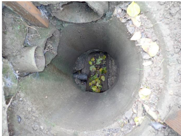
Obr. 43 Kanalizační šachta Š1 (vnitřek) [zdroj foto: V. Shamko]
