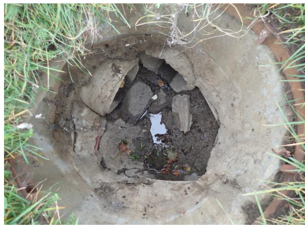
Obr. 53 Kanalizační šachta Š11 (vnitřek) [zdroj foto: V. Shamko]
