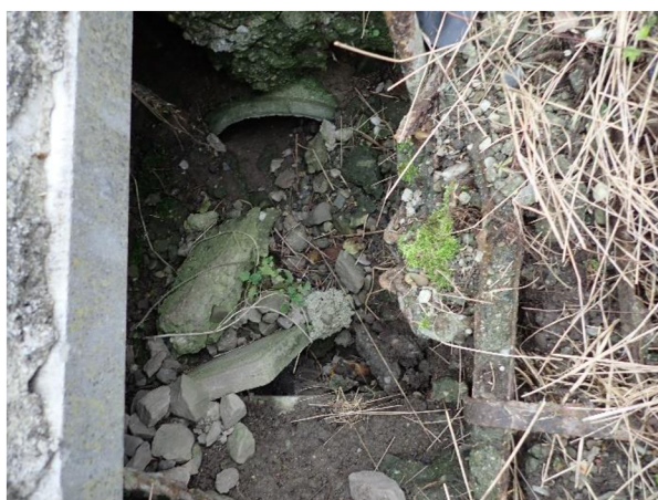
Obr. 51 Kanalizační šachta Š9 (vnitřek) [zdroj foto: V. Shamko]
