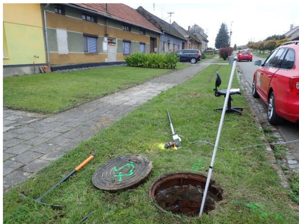
Obr. 46 Kanalizační šachta Š7 (lokalizace) [zdroj foto: V. Shamko]
