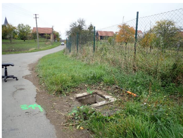
Obr. 54 Kanalizační šachta Š14 (lokalizace) [zdroj foto: V. Shamko]
