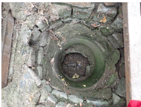
Obr. 49 Kanalizační šachta Š8 (vnitřek) [zdroj foto: V. Shamko]
