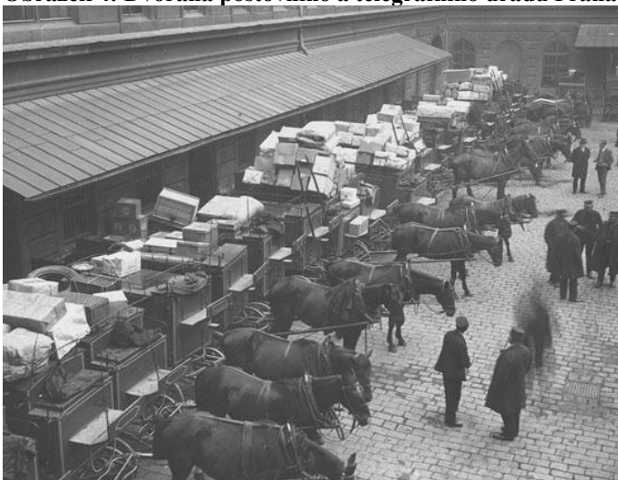
Obrázek 4: Dvorana poštovního a telegrafního úřadu Praha 1, rok 1928
