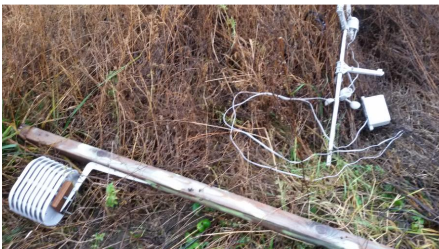
Obr. 66. Problémy s nefunkčním anemometrem způsobené těžkou polní technikou, zdroj: vlastní fotografie
