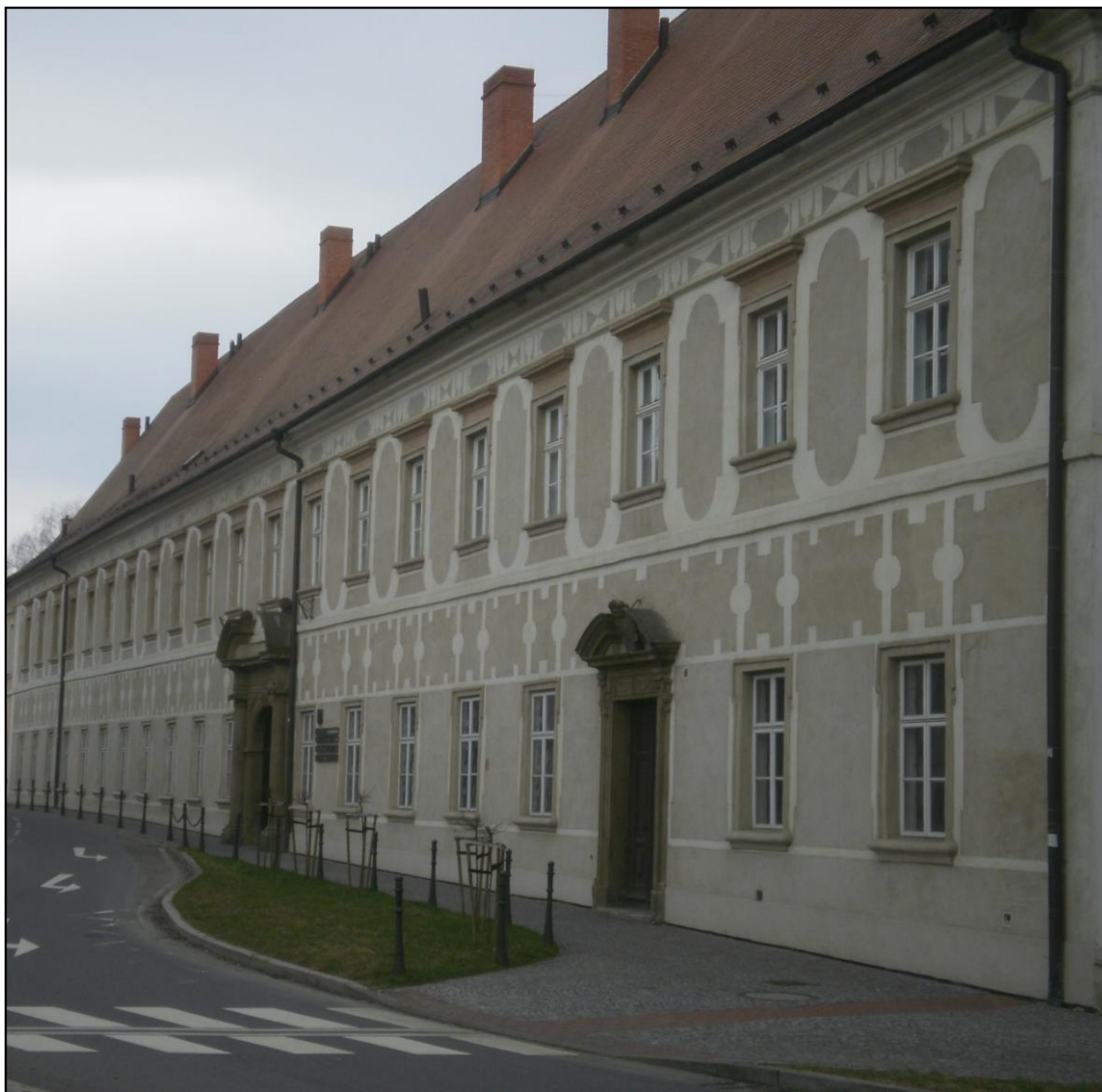
Obr. 9: Piaristický klášter v Příboře
