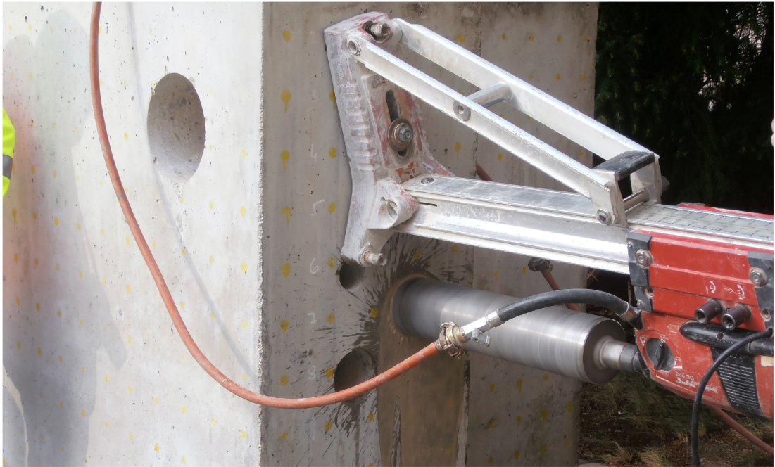
Obr. B.2: Odběr jádrového vývrtnu
