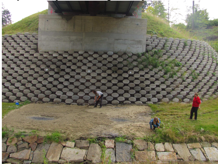
Obr. č. 10: Údržba výzkumné pískové v migračním podchodu na koridoru Celnice
