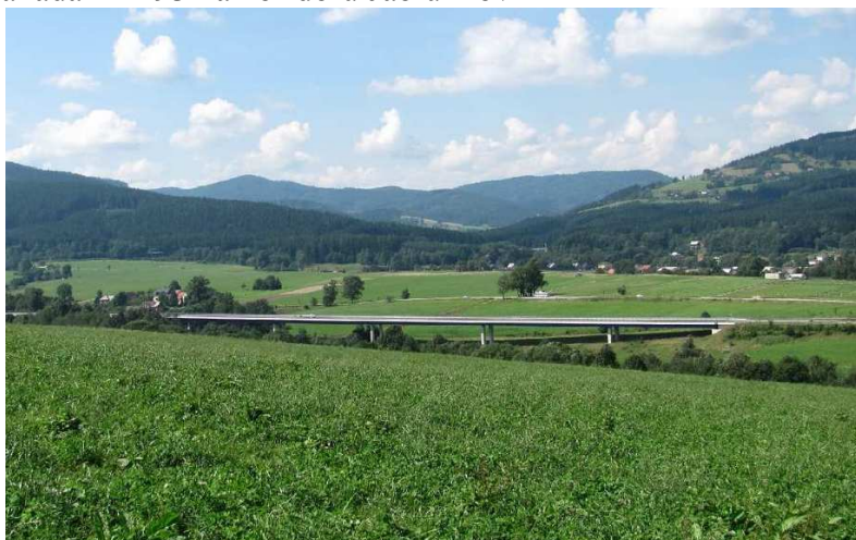
Obr. č. 3: Estakáda 11-193 na koridoru Jablunkov
