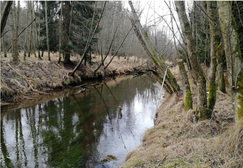
obr. 37. Typický snímek z úseku 4, narovnané kapacitní a zahloubené koryto v lesním komplexu.
