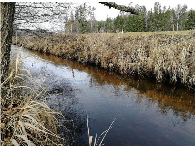
obr. 38. Zahloubené kapacitní koryto v úseku 6, s patrným opevněním z laťových plůtek mezi hladinou a hranicí travního porostu.
