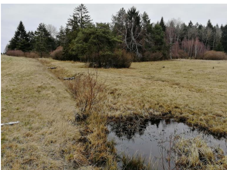
obr. 49. Prameniště Kateřinského potoka, maloplošně chráněné území v horní části obrázku. Ve spodní části obrázku jsou vidět přehrážky v původně zmeliorovaném toku, které mají za úkol zadržet vodu a zvýšit hladinu podzemní vody.
