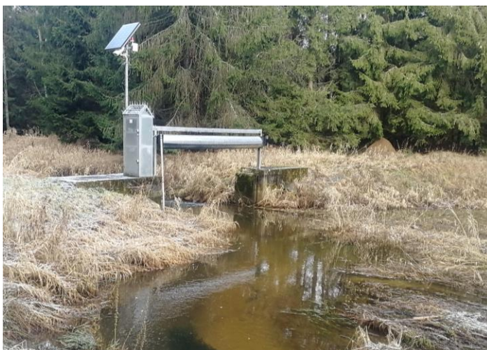
obr. 34. Úsek 2 začíná nornou stěnou za poldrem, která je zde zbudována pro případ havárie ropovodu, křížícího Kateřinský potok v ř. km 8,200-8,300.
