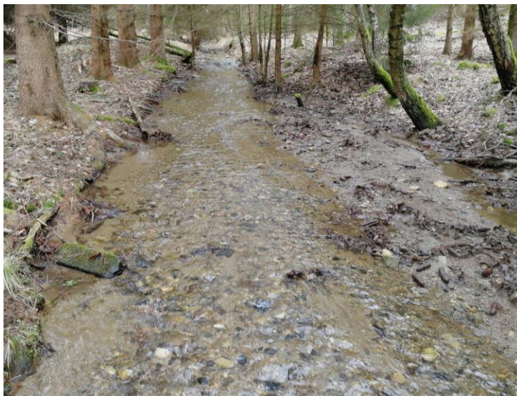
obr. 47. V úseku 22, který prochází lesním komplexem smrkových monokultur je tok regulován a pročišťován.
