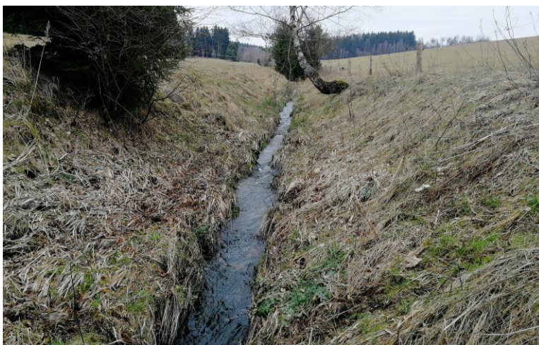
obr. 48. Zhloubené, napřímené, dlážděné koryto v úseku 23 je výsledkem meliorací horního toku. Voda je rychle odváděna z území.
