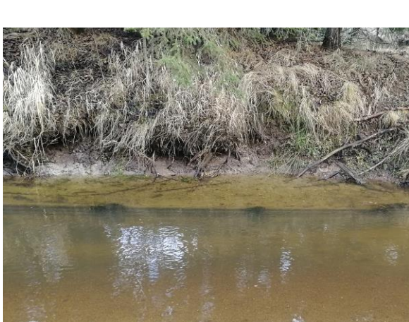
obr. 33. Viditelné opevnění laťovými plůtky v nátrži v úseku 1.
