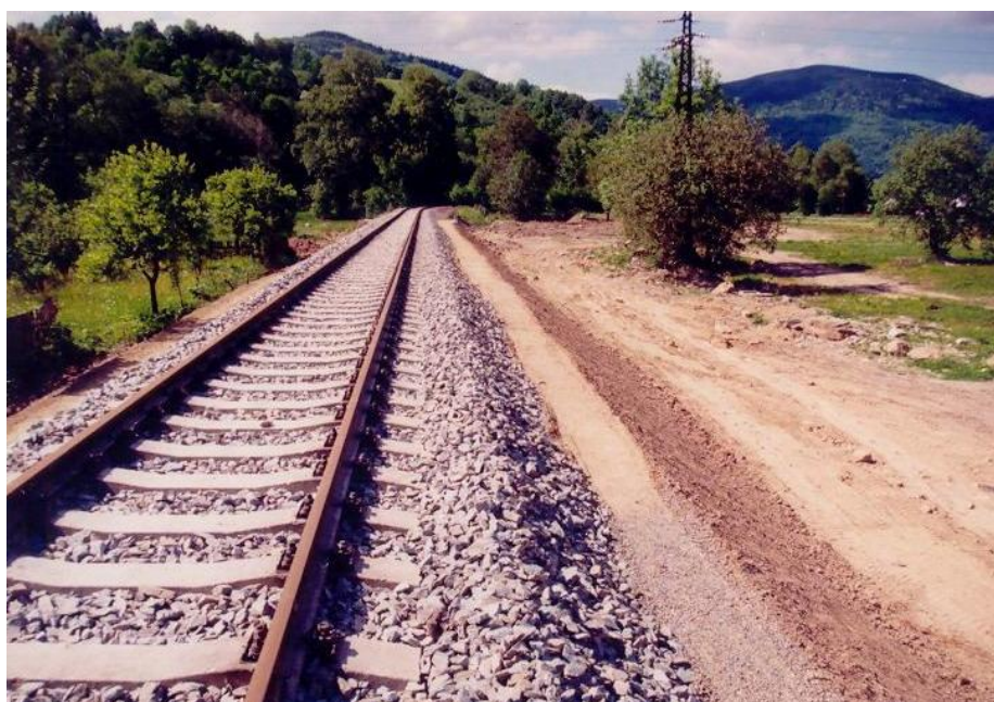
Opravená trať mezi obcemi Velké Losiny a Loučná nad Desnou.
