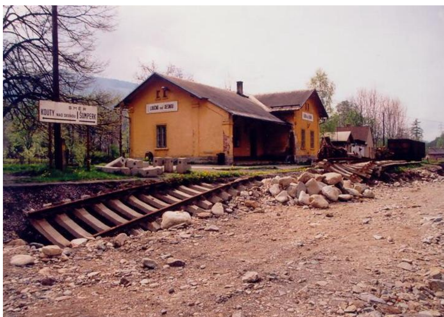
Povodní zničené nástupiště v Loučné nad Desnou.
