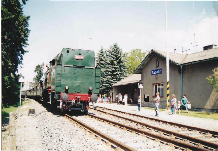
Rekonstrukce železniční tratě - stanice Rapotín.
