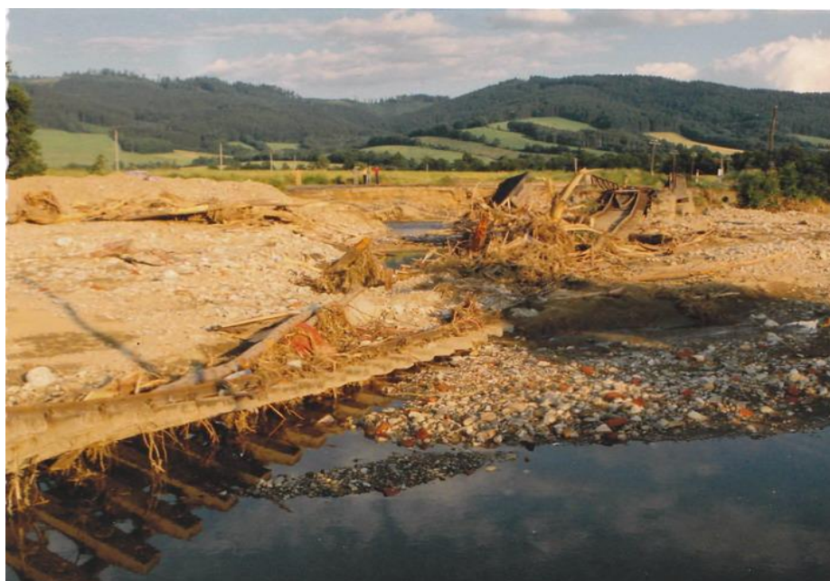
Zničený železniční most přes řeku Desnou.
