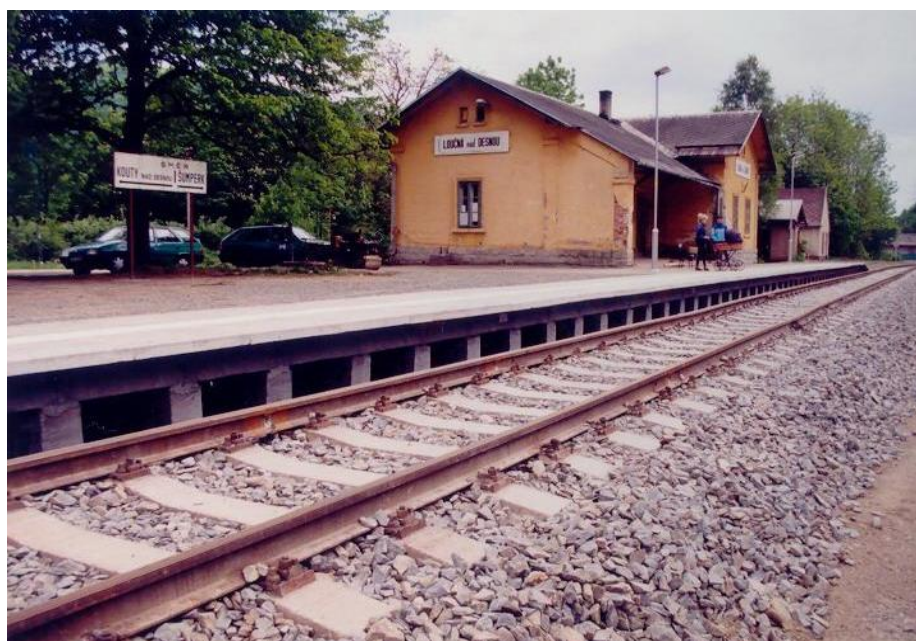
Rekonstrukce nástupiště v Loučné nad Desnou.
