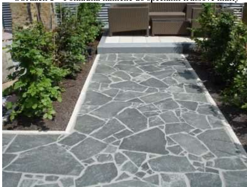
Obrázek 1 – Pokládka kamene do speciální trassové malty
