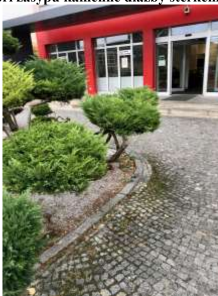
Obrázek 2 – Vady při zásypu kamenné dlažby štěrkem u PEF ČZU v Praze
