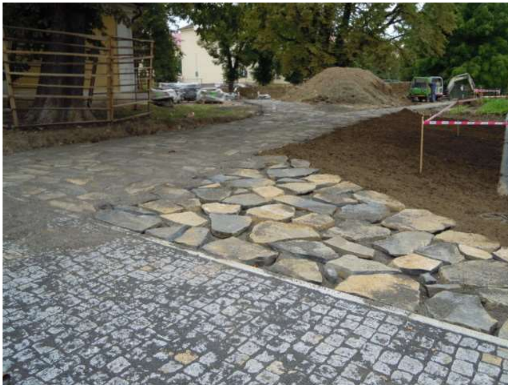
Obrázek 3 – Pokládka dvou druhů kamenů se štěrkem
