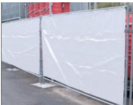
Obr. 50: mobilné oplotenie staveniska zabraňujúce vzdušnému roznášaniu pôdy
