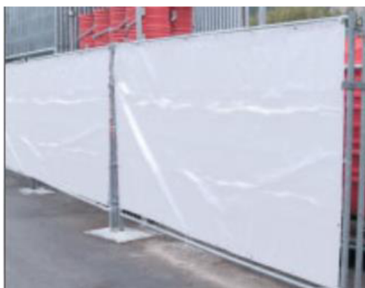
Obr. 50: mobilné oplotenie staveniska zabraňujúce vzdušnému roznášaniu pôdy
