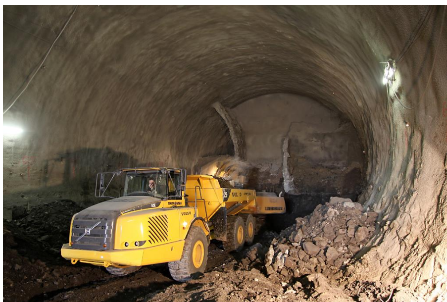
Obr. 7 – Odvoz vytěžené rubaniny z ražené tunelové trouby
