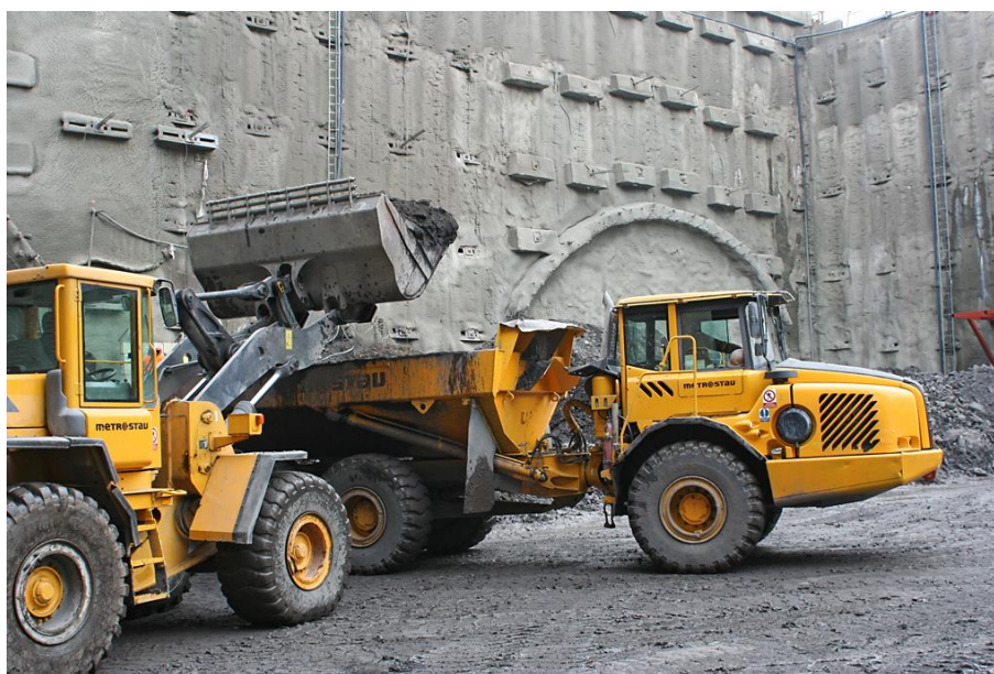
Obr. 17 – Nakládka a odvoz rubaniny z realizace tunelové stavby
