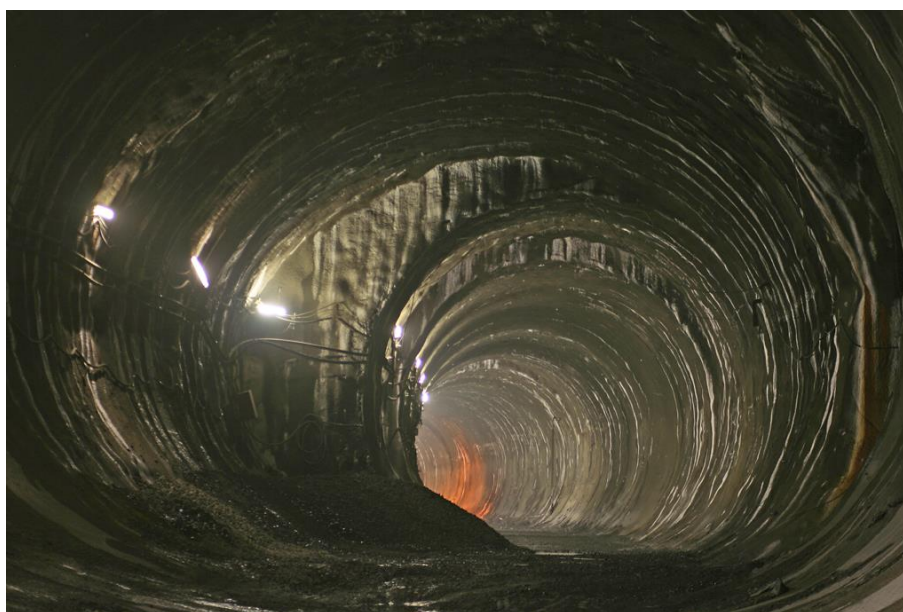
Obr. 2 – Ražená tunelová trouba po provedení primárního ostění
