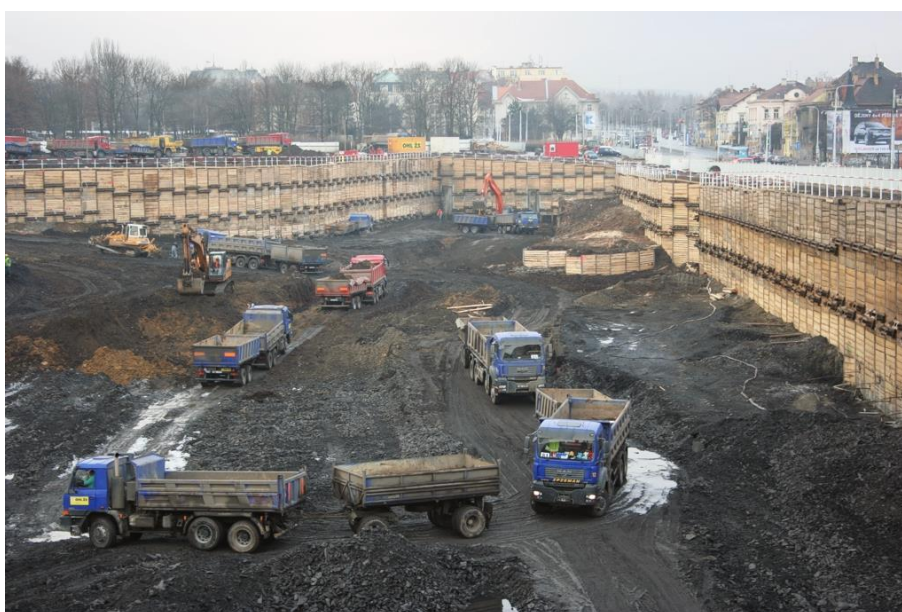
Obr. 32 – Nákladní automobily čekající na nakládku a odvoz vytěžených zemin
