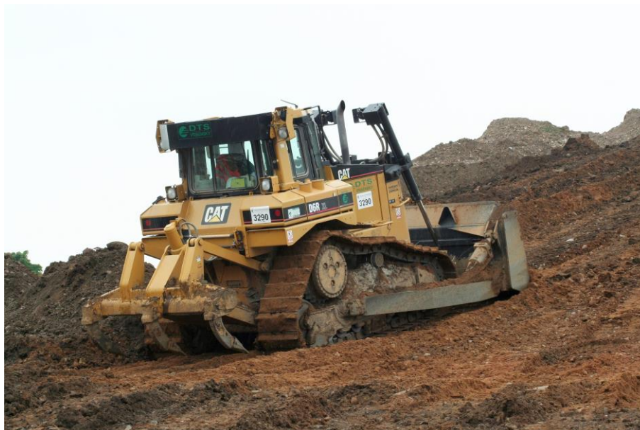
Obr. 18 – Úprava a zabezpečení deponie vytěžených zemin
