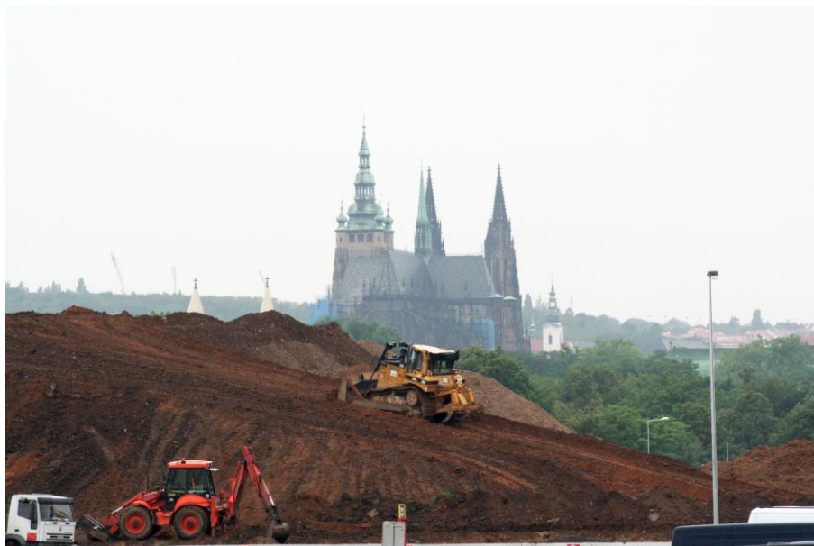
Obr. 15 – Deponování vytěžené zeminy z výstavby městské tunelové stavby
