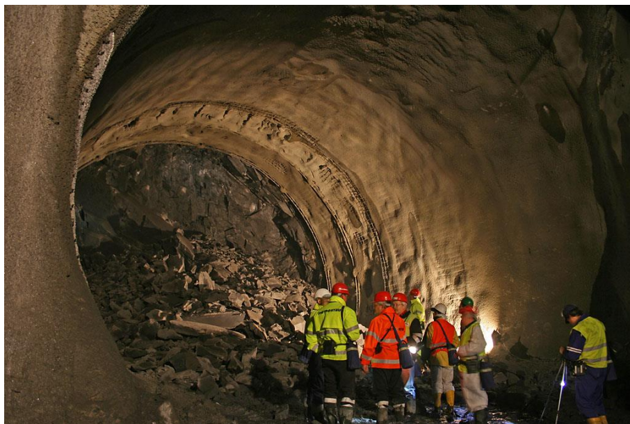
Obr. 1 – Kontrola průběhu ražby tunelové trouby
