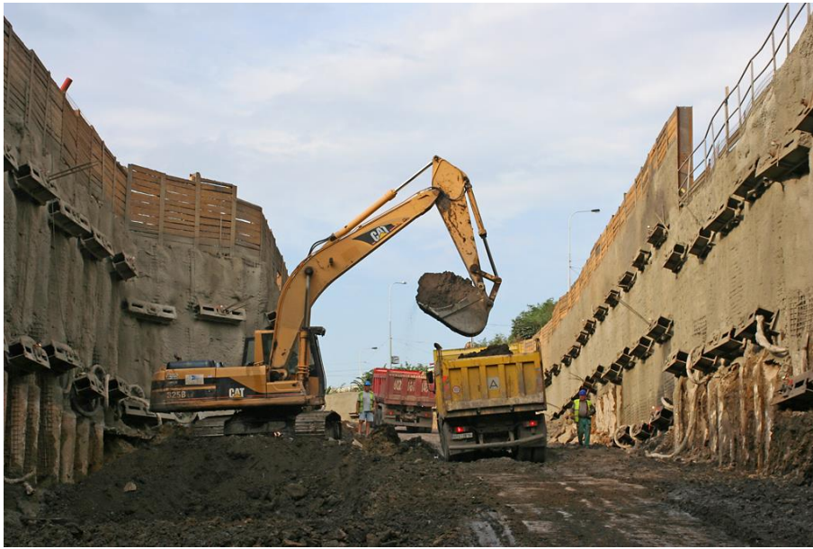
Obr. 16 – Odtěžování výkopové zeminy z hloubené stavební jámy
