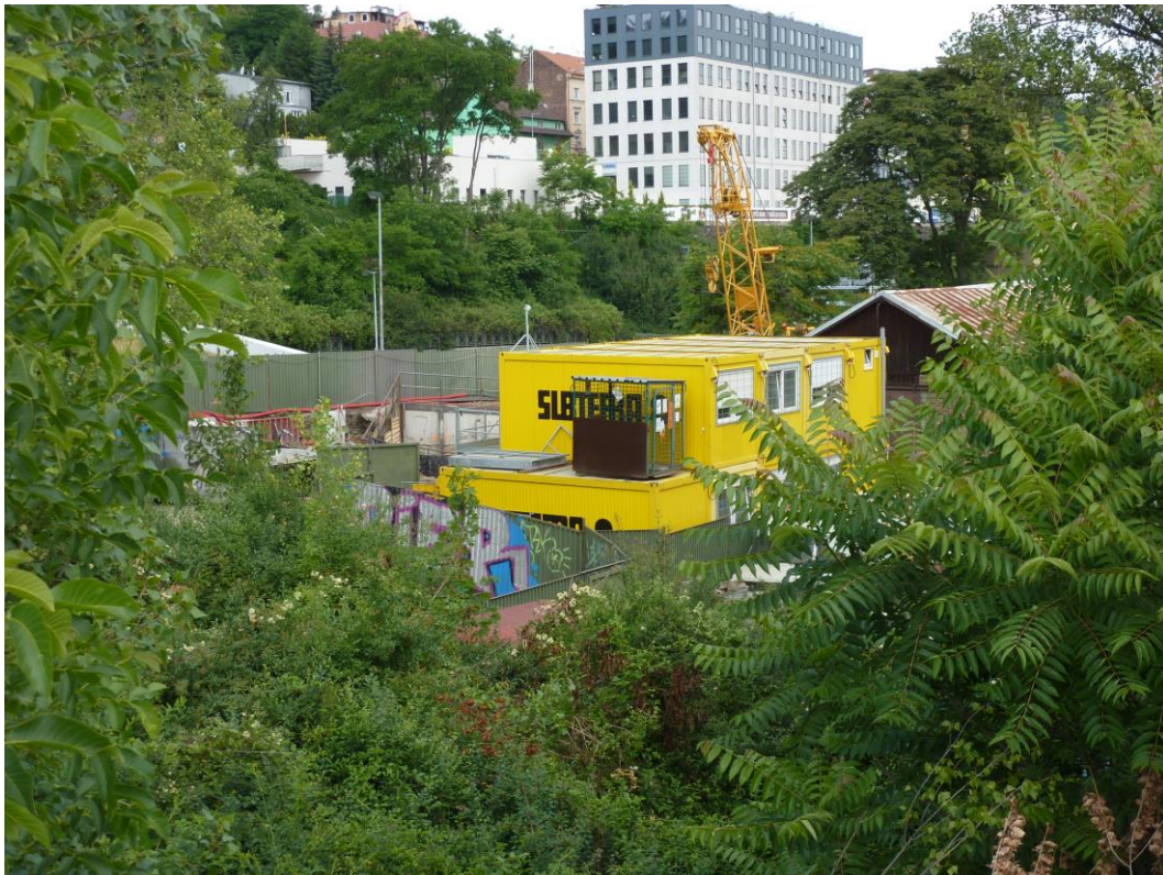
Fotografie č. 1 – Budování zařízení staveniště
