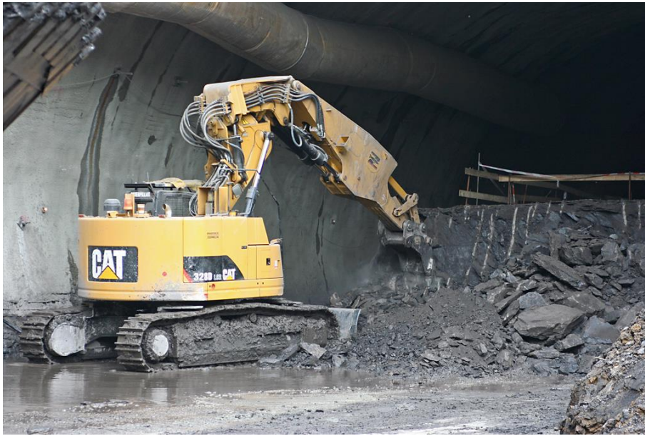
Obr. 8 – Odtěžování zeminy v ražené tunelové troubě
