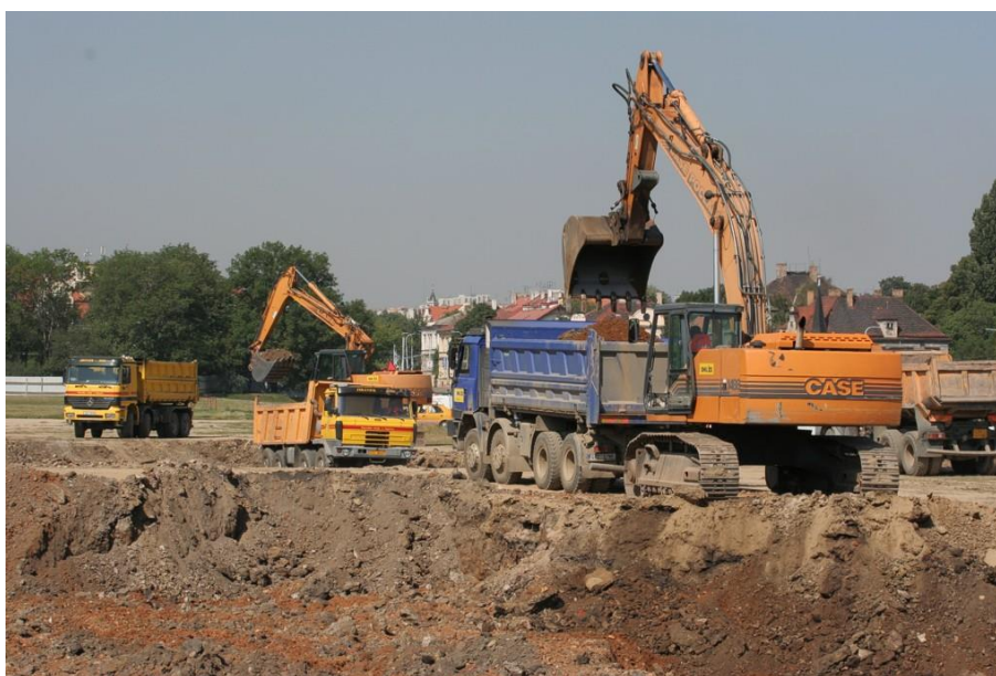
Obr. 13 – Odtěžování a nakládání výkopové zeminy při hloubení stavební jámy
