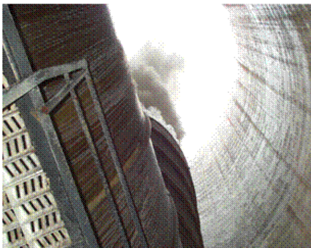
Obr. 4: Pohled na vývod odsíření z vnitřní části věže (zdroj: ČEZ)
