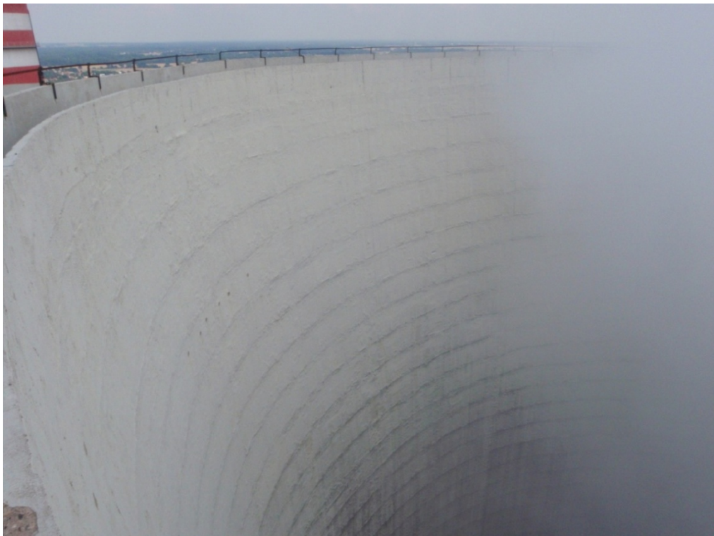
Obr. 7: Pohled do aktivní věže s vyvedeným odsířením, která je zcela bez osídlení
