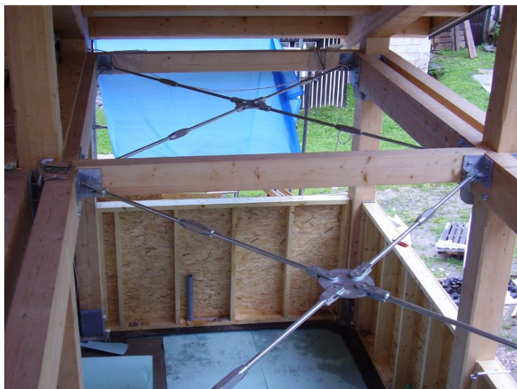
Obrázek č. 24 Řešení ocelových táhel ve stěnách a střeše (Vala, 2018)
