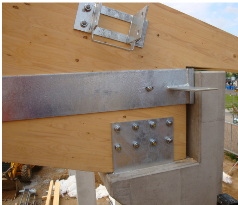
Obrázek č. 22 Detail řešení ocelového táhla (PrvníStatická, ©2018)
