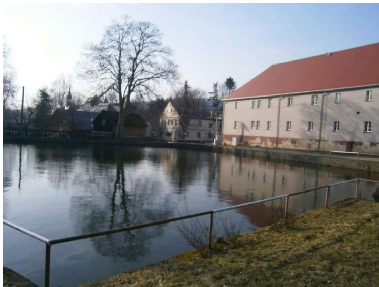
Obrázek 2 – Zadní část budovy s požární nádrží
