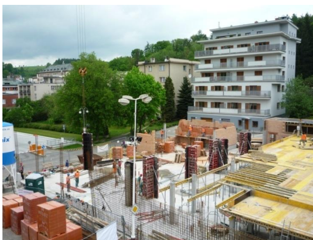
Obrázek 19 - Svislé konstrukce [vlastní zdroj]
