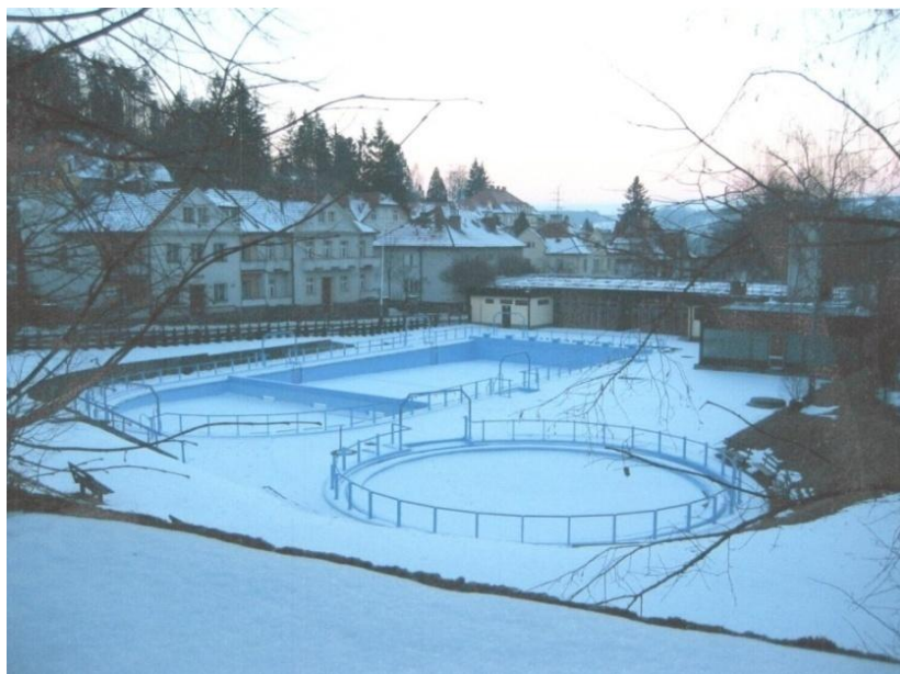
Obrázek 11 - Pohled na plovárnu v roce 2003 [16]
