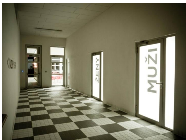
Obrázek 21 - Chodba a pohled na vnitřní omítku [16]
