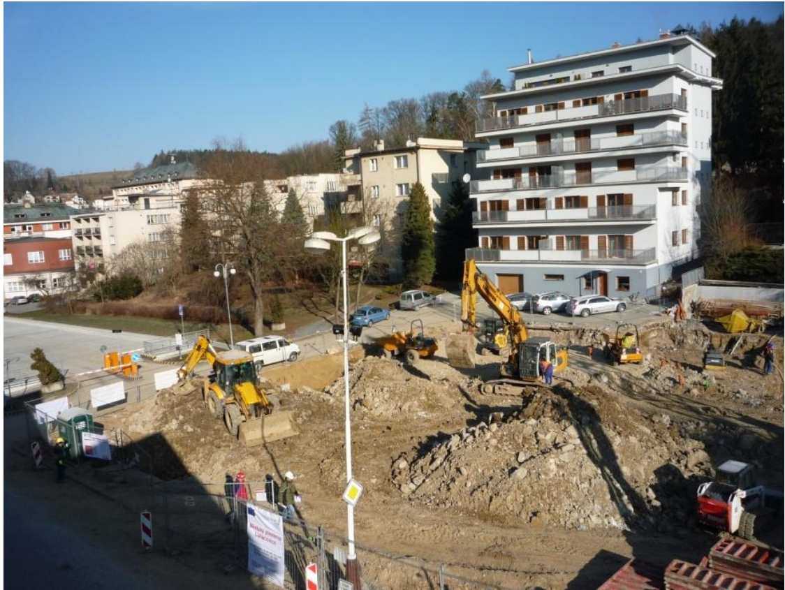
Obrázek 17 - Výkopové práce [vlastní zdroj]
