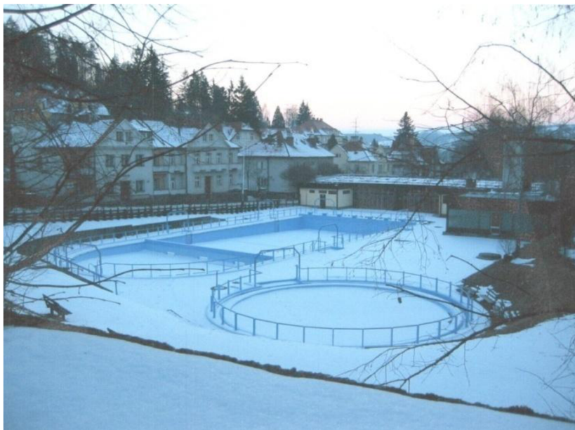
Obrázek 11 - Pohled na plovárnu v roce 2003 [16]
