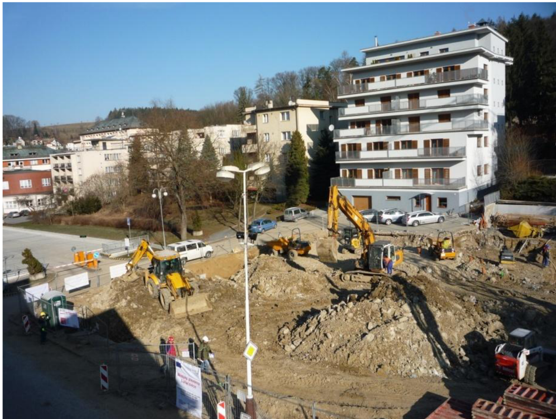
Obrázek 17 - Výkopové práce [vlastní zdroj]
