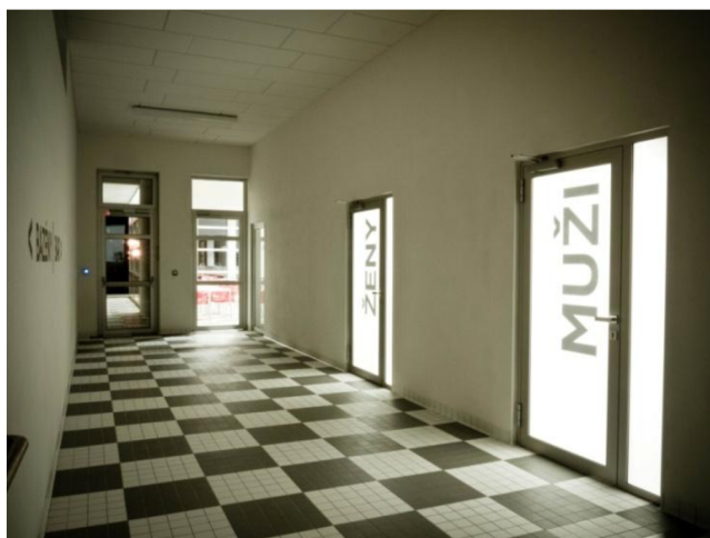
Obrázek 21 - Chodba a pohled na vnitřní omítku [16]
