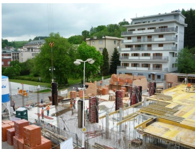
Obrázek 19 - Svislé konstrukce [vlastní zdroj]
