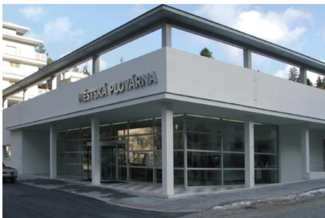
Obrázek 22 - Vstup do plovárny a pohled na vnější omítku [16]
