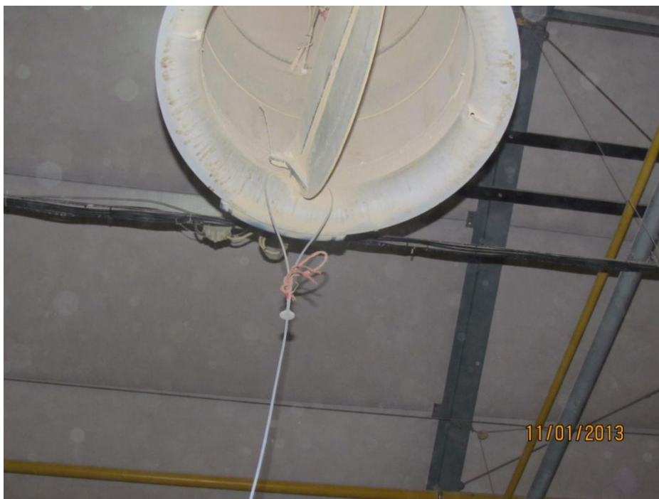
Obrázek č. 16 – Umístění sondy ve výšce 2,5 m nad zemí, zdroj: KUBÁŇ, (2013)
