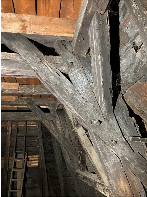
Obrázek 1.21: Pohled na pásek plné vazby VII (vlevo) a pásek podélného zavětrování (vpravo nahore), 2. úroveň, západ.
