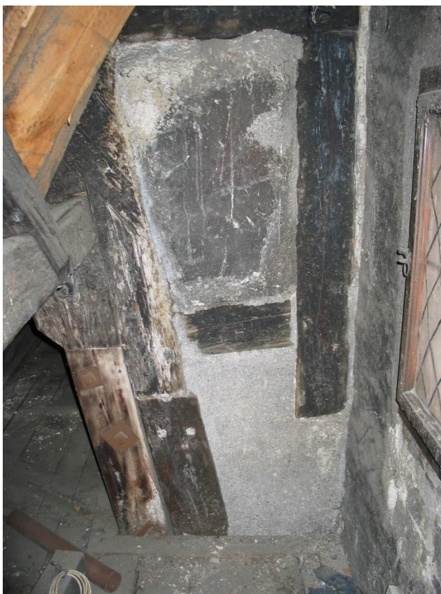
Obrázek 1.10: Pohled na protězy ležatého sloupku, krokve a hrázdění boční stěny severního vikýře.
