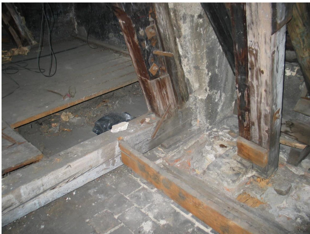
Obrázek 1.11: Pohled na odkrytou patní část krovu (1. úroveň, východ). Protézovaný ležatý sloupek a krokve plné vazby IIII, které jsou spojené s novým vazným trámem mělkým zapuštěním, zajištěným kramlí. Nový vazný trám je uložen na zděný sloupek (vlevo). Neodborně protézovaná a částečně podezděná nárožní krokve vazby III (vpravo).
