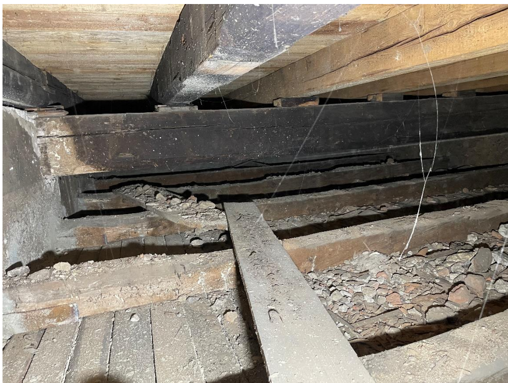
Obrázek 1.27: Celkový pohled do prostoru pod původní stropní konstrukcí nejvyššího podlaží věže. Dole konstrukce v baroku sníženého podhledu. Masivní průvlak podpírá pohledové trámy původního stropu, ze kterých se dochovaly pouze tři (I, II a VII). Ostatní byly nahrazeny novými prvky ze strojně řezaného dřeva.
