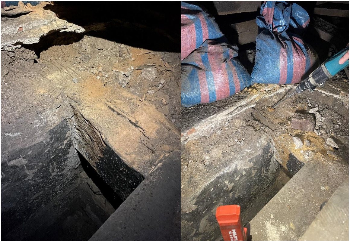
Obrázky 3.2.1 a 3.2.2: Celkový pohled na vyšetřované zhlaví stropního trámu (vlevo), zhotovení vrtané sondy pro endoskop (vpravo).
