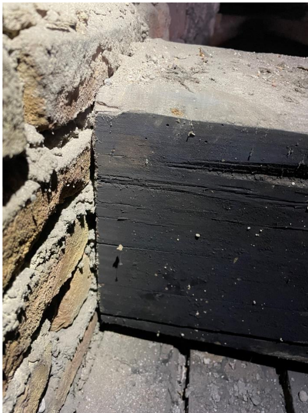
Obrázek 3.8.1: Celkový pohled na měřený prvek. Zhlaví chybí; měření endoskopem nebylo provedeno.
