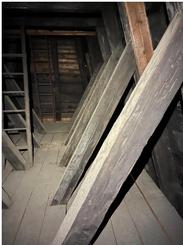
Obrázek 1.22: Pohled na šikmé vzpěry krokvi (3. úroveň, západ).
