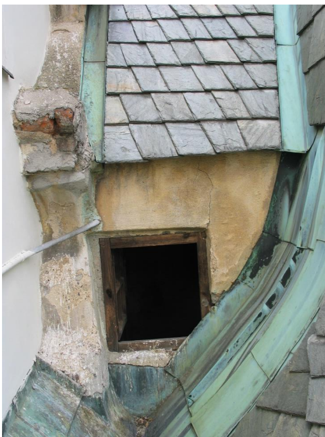
Obrázek 1.6: Pohled na okénko v boční stěně zaslepeného západního vikýře, vlevo stěna Saského domu.
