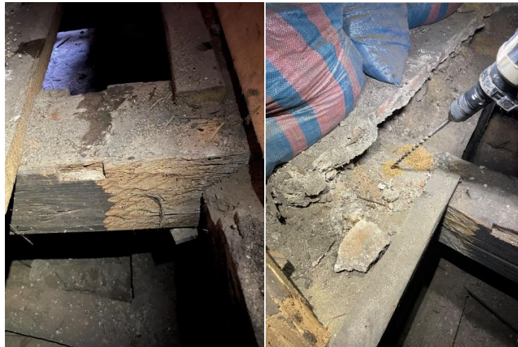
Obrázky 3.3.1 a 3.3.2: Celkový pohled na vyšetřované zhlaví stropního trámu (vlevo), zhotovení vrtané sondy pro endoskop (vpravo).
