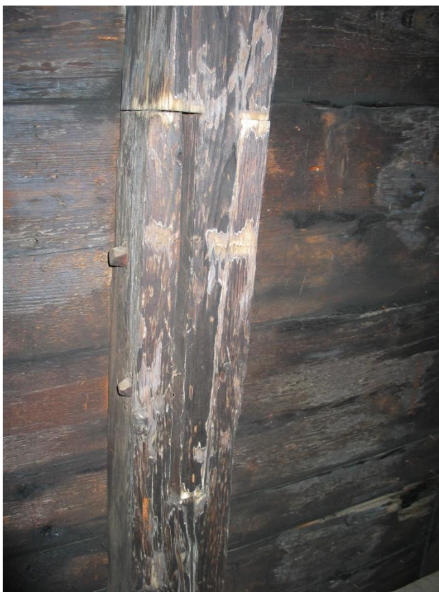
Obrázek 1.23: Detail nastavovacího spoje krokví ve 3. úrovni krovu.
