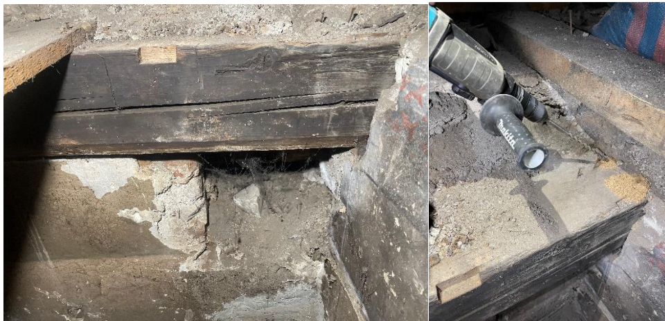
Obrázky 3.6.1 a 3.6.2: Celkový pohled na vyšetřované zhlaví stropního trámu (vlevo), zhotovení vrtané sondy pro endoskop (vpravo).
