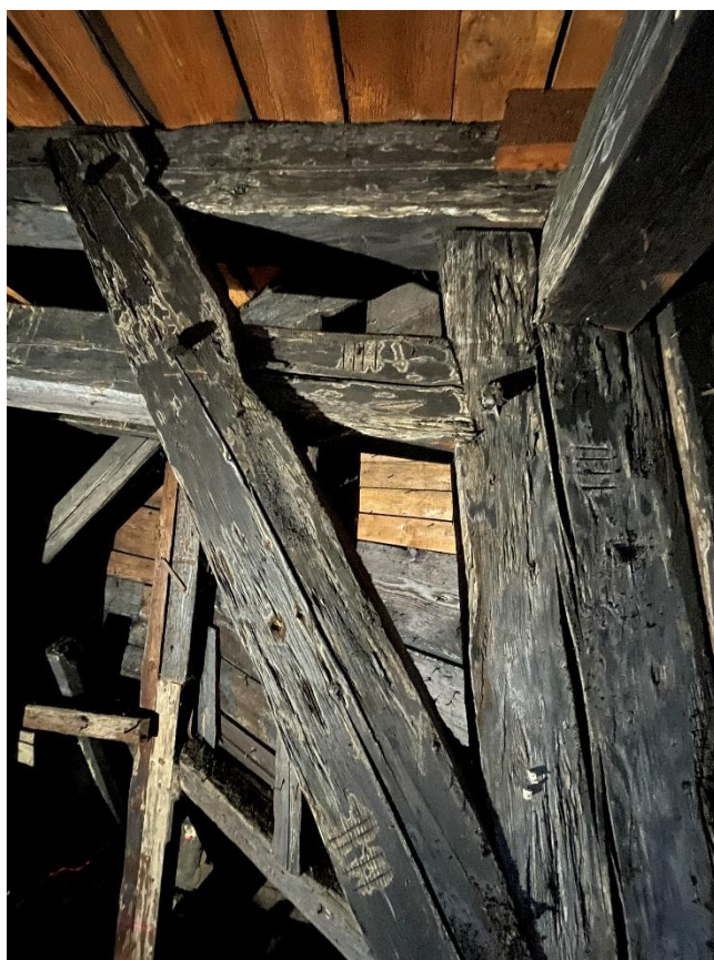
Obrázek 1.8: Pohled na prvky ležaté stolice plné vazby IIII (1. úroveň, západ).
