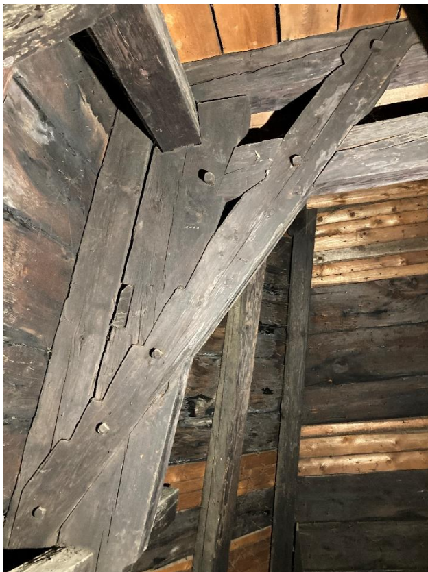
Obrázek 1.20: Pohled na pásek plné vazby IIII s několikanásobně zazubeným plátem (2. úroveň, východ).
