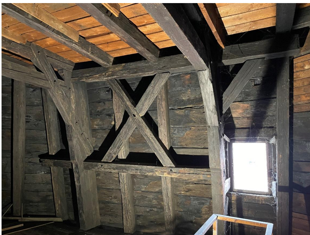
Obrázek 1.18: Pohled na podélné vázání s ondřejským křížem (2. úroveň, západ).
