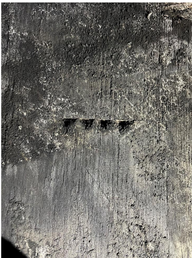
Obrázek 1.25: Detail tesařského značení trojúhelníčky, prvek vazby IIII, východ.
