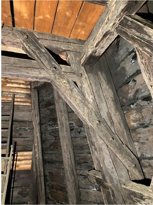
Obrázek 1.19: Pohled na charakteristický „rámový roh“ plné vazby IIII (2. úroveň, západ).
