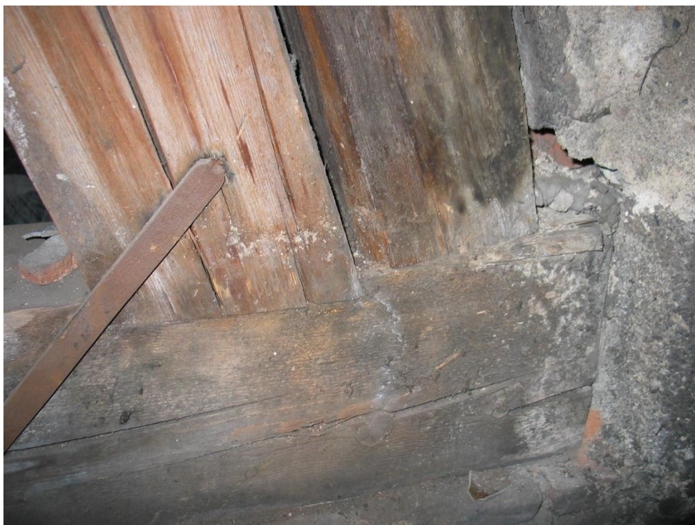
Obrázek 1.12: Detail uložení patní části protézovaného ležatého sloupku a krokve vazby IIII (1. úroveň, východ). Spoj s novým vazným trámem proveden mělkým zapuštěním, zajištěným kramlí.
