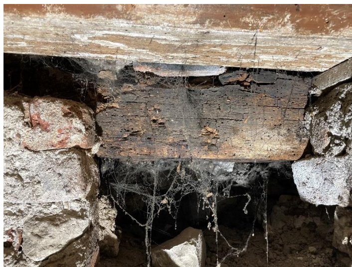
Obrázek 3.5.4: Jižní pozednice (jihozápadní kapsa).
