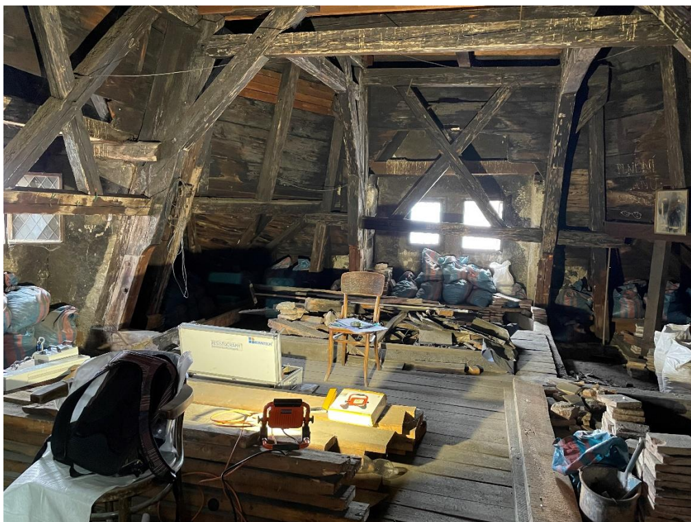
Obrázek 1.7: Celkový pohled do interiéru 1. úrovně krovu.
