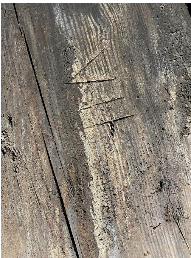
Obrázek 1.26: Detail tesařského značení římskými číslicemi, prvek vazby VII, západ.
