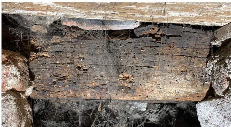
Obrázek 5.1.1.6: Zcela zničená jižní pozednice dřevomorkou (patrný kostkový rozpad) a čevotočem.
