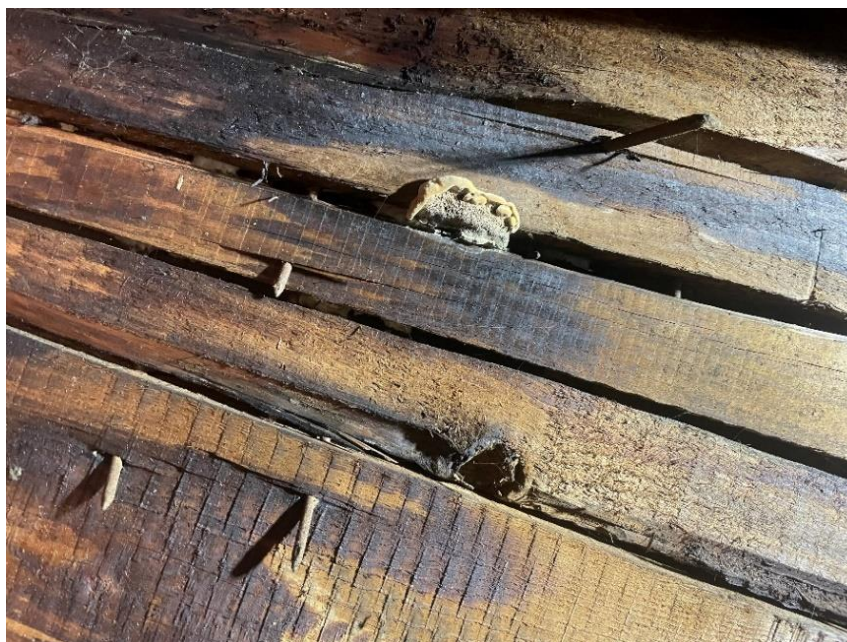
Obrázek 5.1.1.3: Plodnice trámovky na spodní ploše bednění jihovýchodního námětku.
