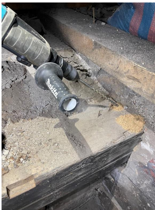
Obrázek 5.3.1.1: Předvrtání otvoru pro endoskop.
