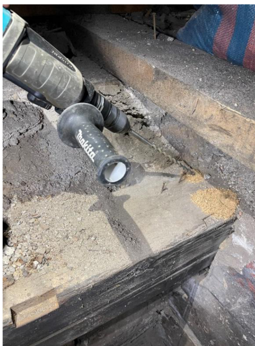
Obrázek 5.3.1.1: Předvrtání otvoru pro endoskop.
