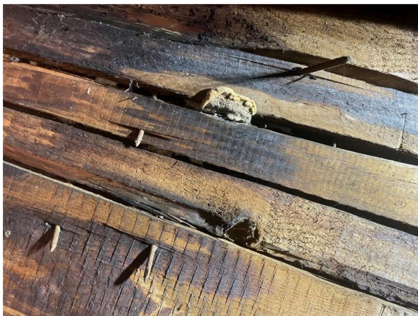
Obrázek 5.1.1.3: Plodnice trámovky na spodní ploše bedněni jihovýchodního námětku.
