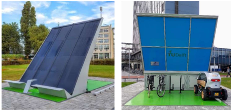
Obrázek 4 - Dobíjecí stanice s využitím solární energie (zdroj: [9])
