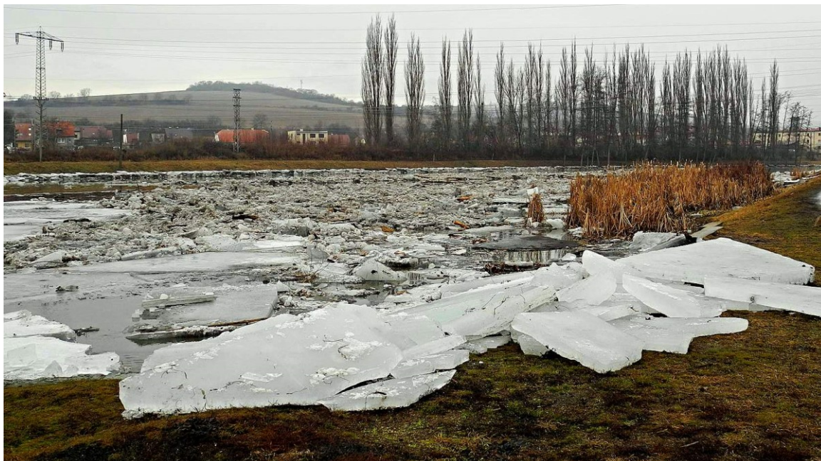
Obr. 2.5 Ledové jevy v nadjezí smíšeného jezu v Oslavanech [9]
