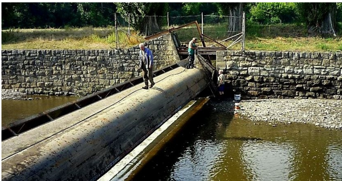
Obr. 4.2 Oprava válcového jezu v roce 2013 [14]
