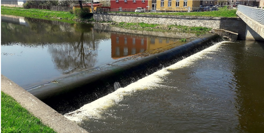
Obr. 4.7 Pevný jez (ř. km 4,969) (D. Němcová 2018)
