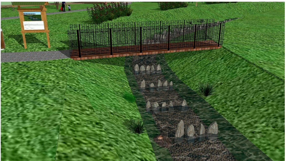
Obr. 8.4 Lávka pro pěší přes rybí přechod a informační tabule
