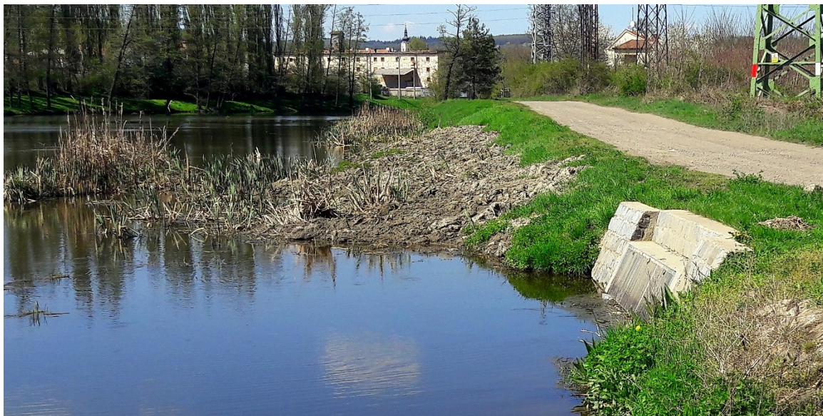
Obr. 4.4 Odběrný objekt do rybochovného zařízení - ř. km 3,055 (D. Němcová 2018)
