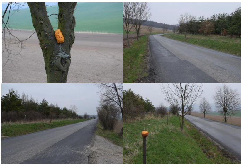
Obr. 59-62: Pohled na rizikový úsek u obce Trubín – opatření pachovými ohradníky (vlastní)
