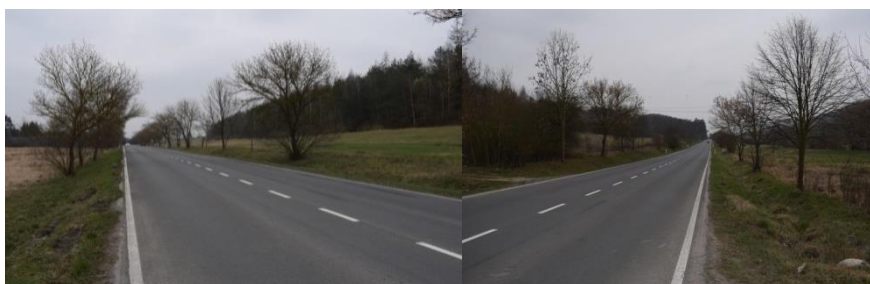
Obr. 31, 32: Pohled na rizikový úsek - silnic č. 605 a 118 lemující dálnici D5 u exitu 14 (vlastní)
