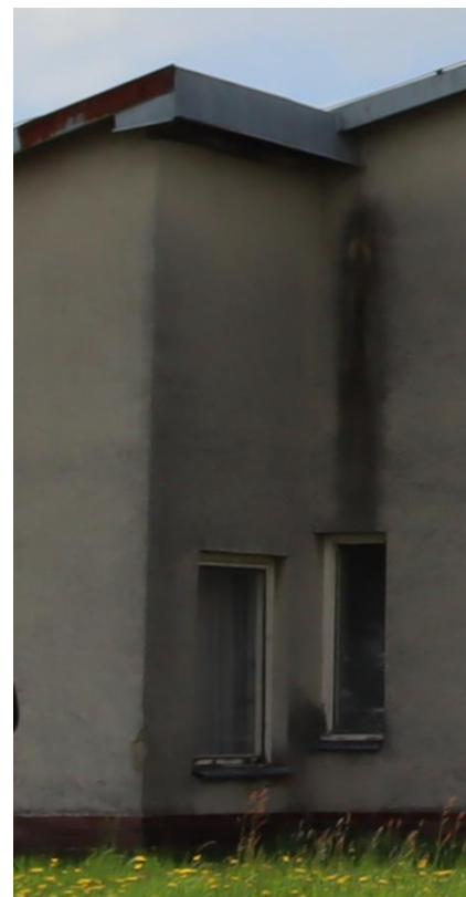
Obrázok 15 - Nevhodné utesnenie klampiarskych prvkov - tmavé flaky na fasáde
