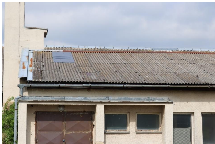
Obrázok 10 - po škodené klapiarske prvky
