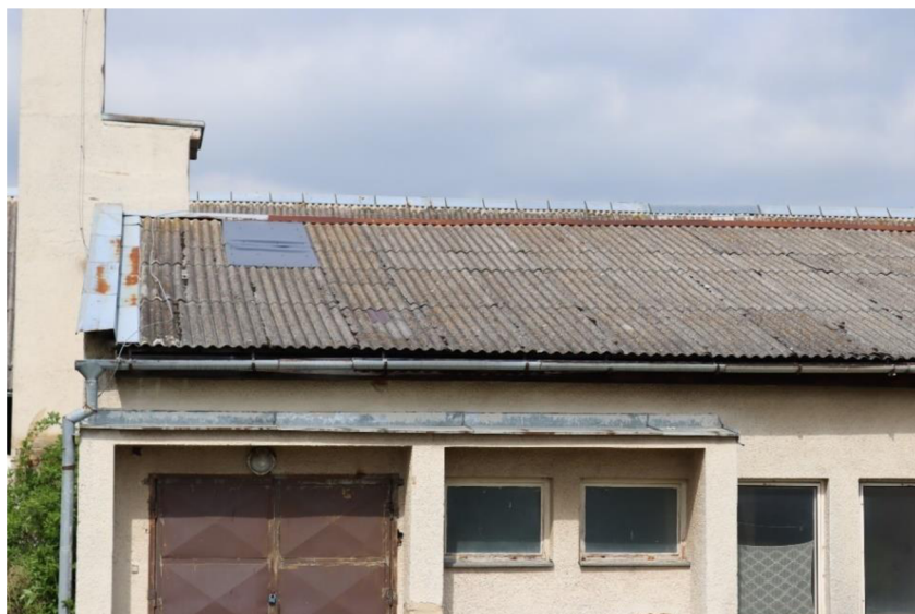
Obrázok 10 - po škodené klapiarske prvky
