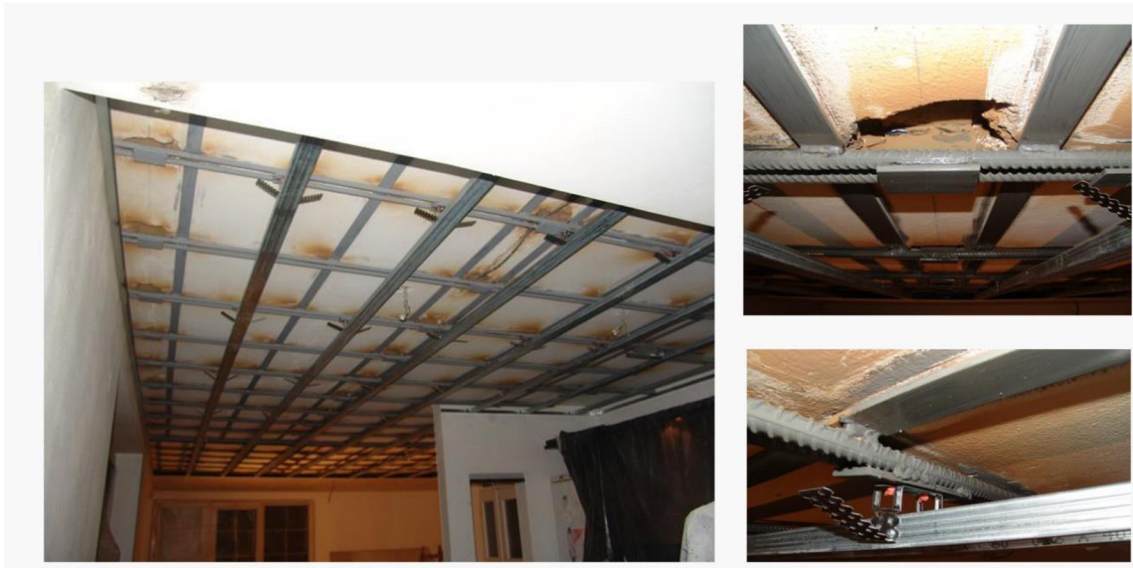
Obrázok 9 - Samonosná ocelová konštrukcia na prípadnú opravu Hurdis dosiek [5]
