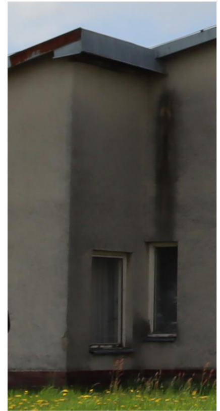
Obrázok 15 - Nevhodné utesnenie klampiarskych prvkov - tmavé flaky na fasáde
