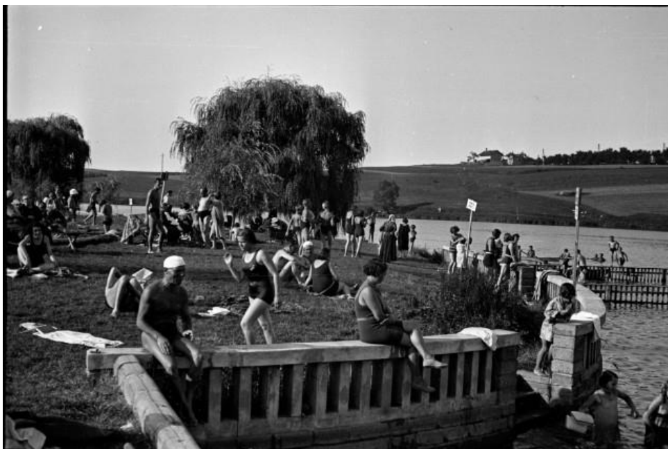
Obr. 12 Sokolská plovárna, r. 1932.
