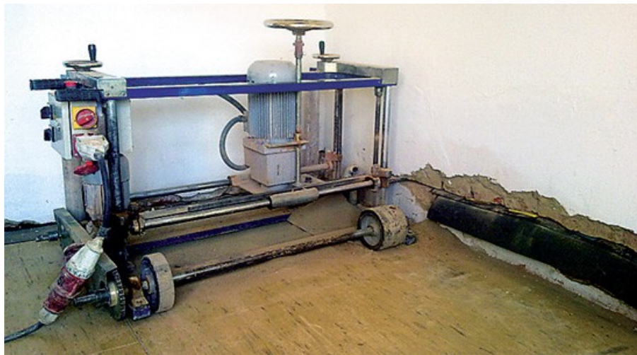
Obr. 15 - podřezávání zvlhlého zdiva
