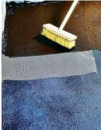
Obr. 7 - princip nanášení asfaltové izolace
