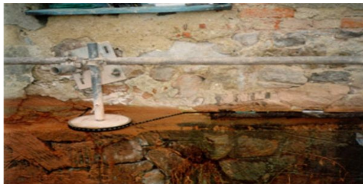
Obr. 17 – podřezání zdiva lanovou pilou
