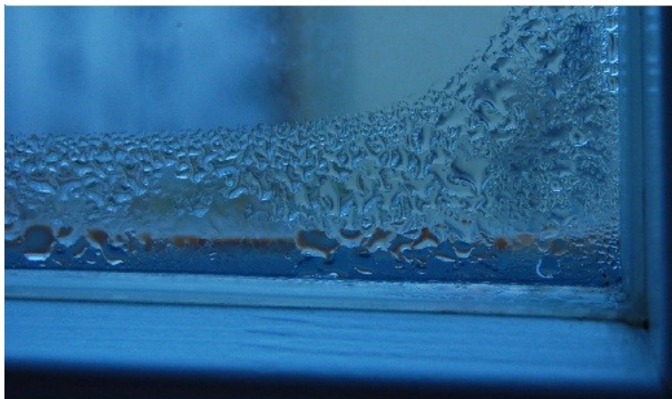
Obr. 3 - orosené okno uvnitř místnosti
