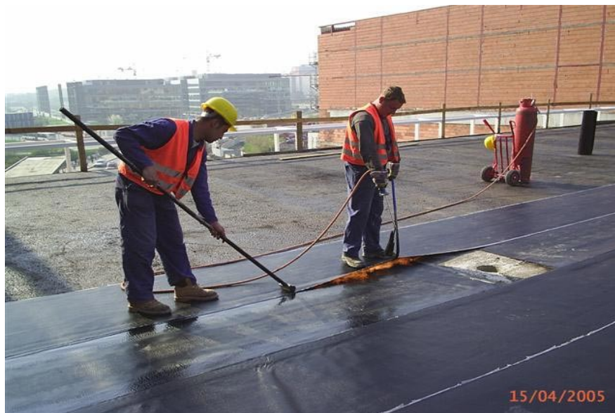
Obr. 8 - nanášení izolačních pásů za pomoci propanbutanového hořáku
