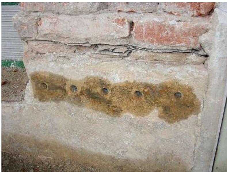
Obr. 13 – injektáž zvlhlého zdiva
