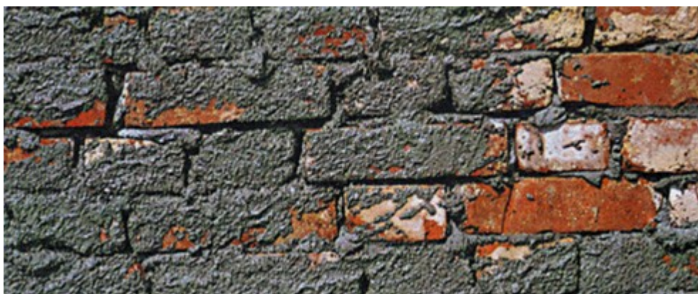
Obr. 10 - omítkový podhoz
