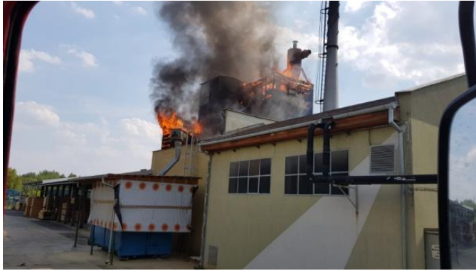
Obr. 3: Požár zásobníku pevných a sypkých hmot, pila Vrchoslav
