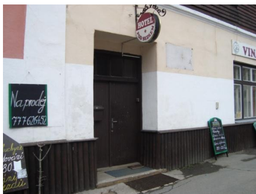
Obrázek 1. Vstup do objektu
