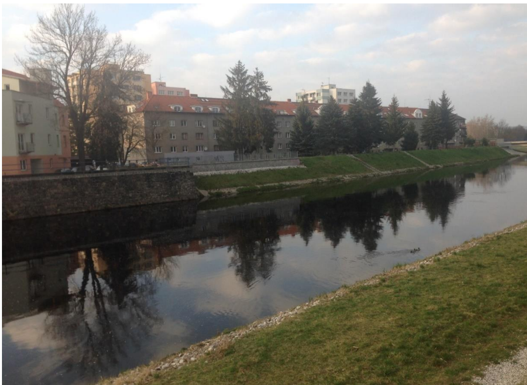
Příloha 6 k textu na str. 23 – SO 05 od mostu Ellerova po konec kamenné nábřežní zdi – levý břeh (Hájková, 2019)
