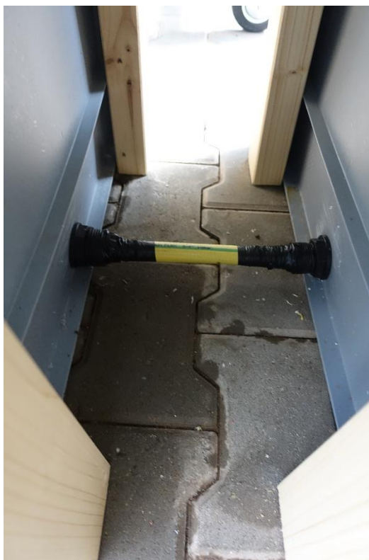
Obr. č. 31: Spojení retenčních nádrží
