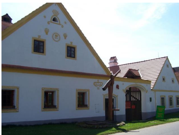
Obrázek č. 33: Usedlost v Holašovicích
