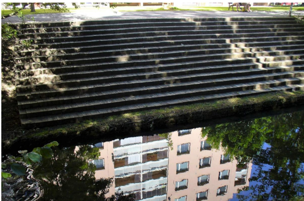
Obr. 3 - Hodnotně pojedené nábřeží řeky Loučné, jakožto doklad svého druhu vysoce ceněného krajinného zázemí sídliště Komenského náměstí v Litomyšli. Provedená revitalizace vč. regenerace přilehlého panelového sídliště je dílem Ing. arch. Josefa Pleskota. Zdroj: (Autor, 2017).
