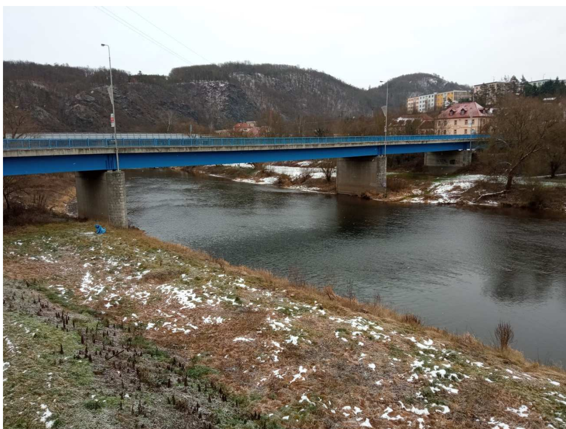
Obrázek 40 silniční most v Roztokách u Křivoklátu
