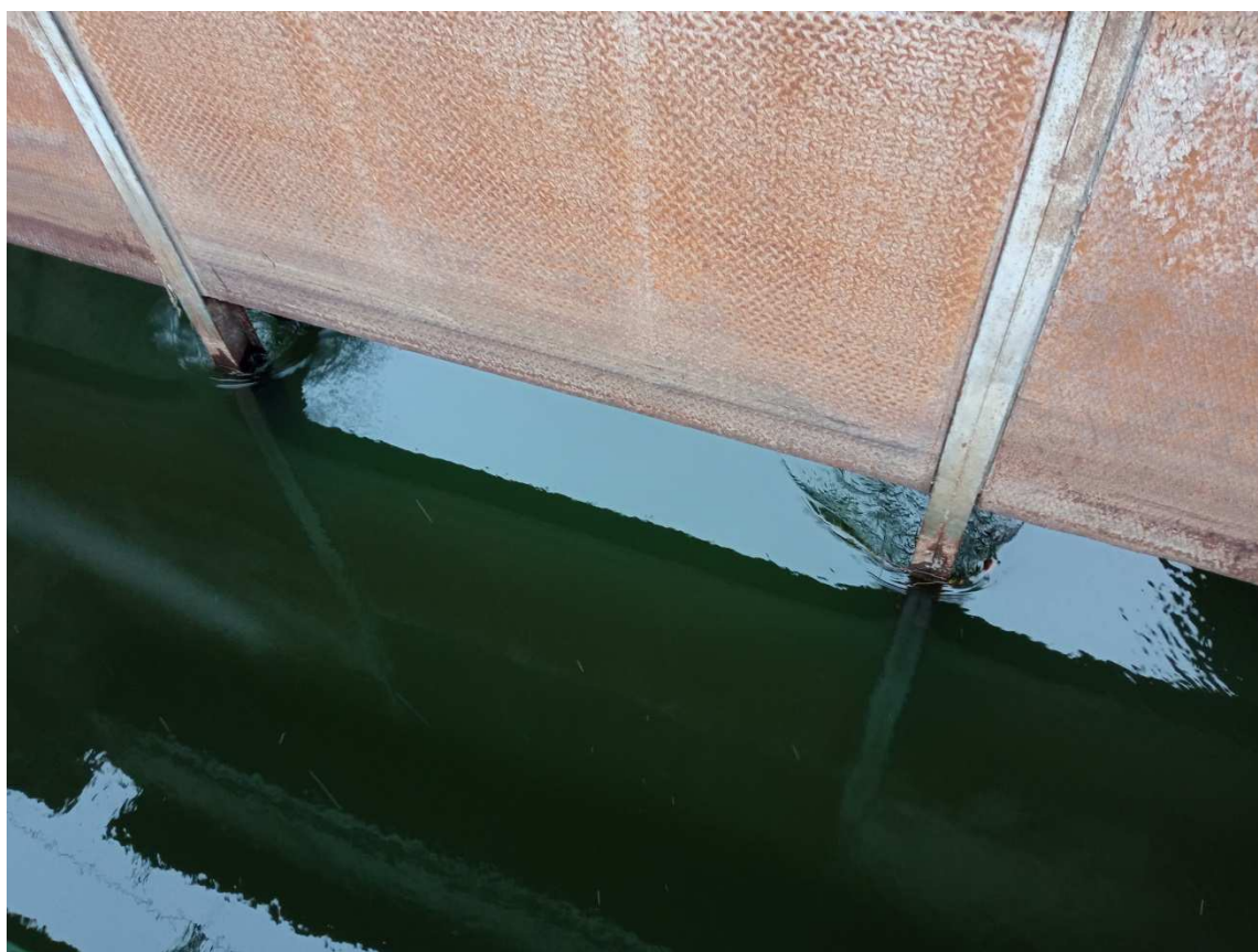
Obrázek 30 vtok do náhonu elektrárny v Roztokách u Křivoklátu
