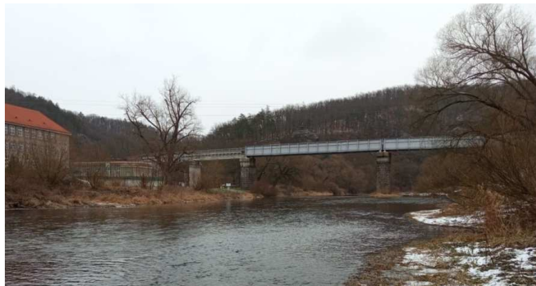
Obrázek 42 železniční most v Roztokách u Křivokláta
