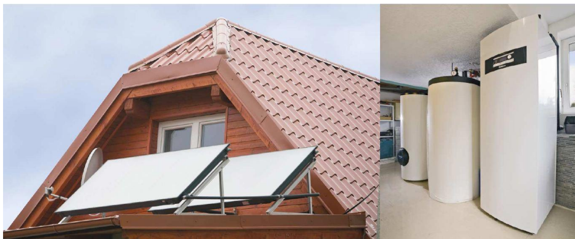
Obr. 9 - Další příklad instalace tepelného čerpadla v kombinaci se solárními panely
