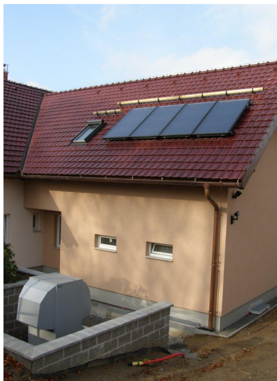
Obr. 8 - Příklad instalace tepelného čerpadla v kombinaci se solárními panely
