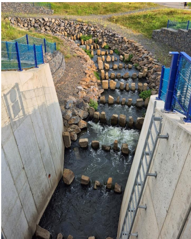
Obr. 7: Rybí přechod u jezu na řece Bečvě v Hranicích (zdroj: Havranová, 2024)
