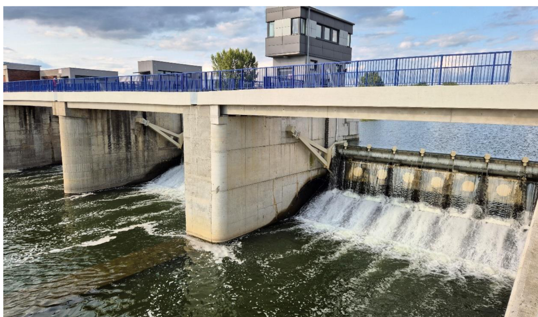
Obr. 6: Jez na řece Bečvě v Hranicích (zdroj: Havranová, 2024)
