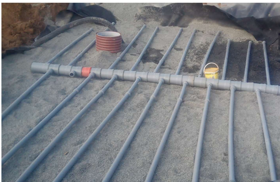
Obr. 12: foto z průběhu stavby - rozvod vody na ploše kořenového filtru, zdroj: archiv autora (2019)
