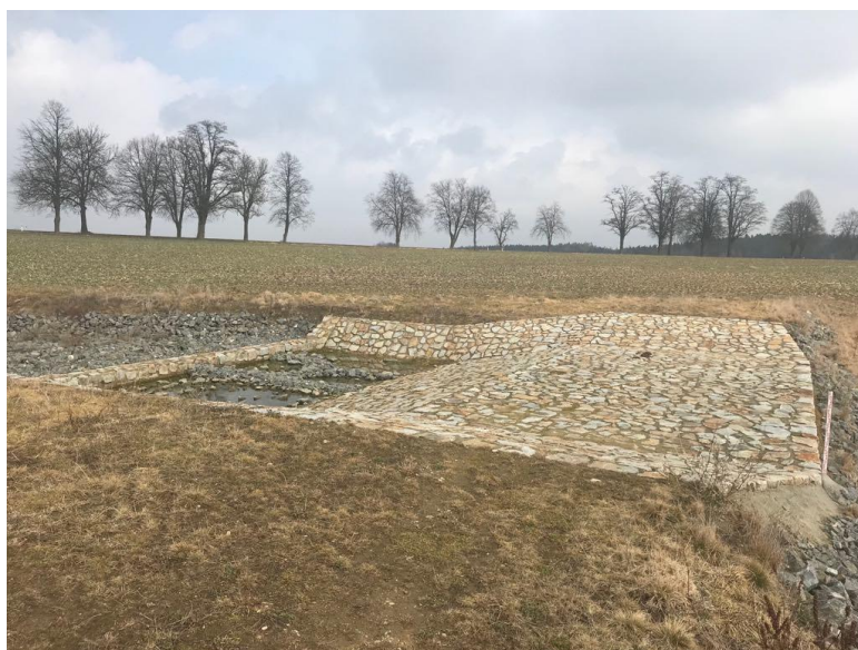
Obr. č. 6. suchá nádrž Košice
