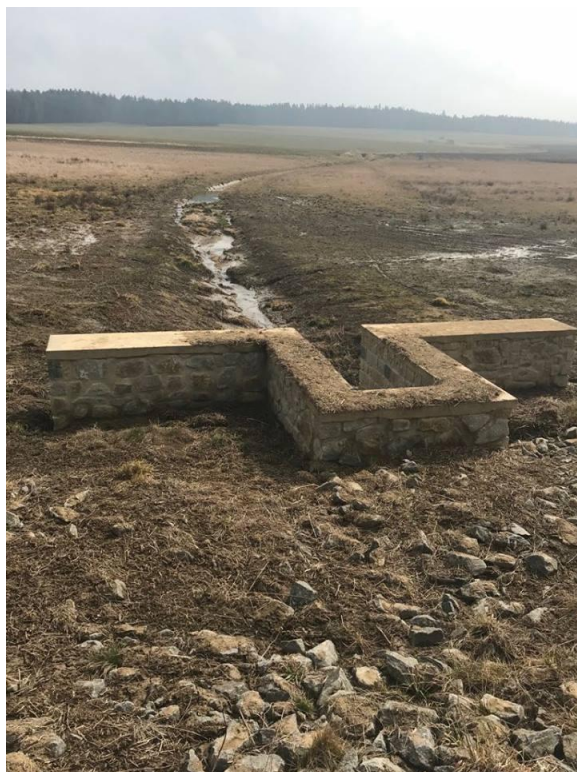
Obr. č. 7. suchá nádrž Košice
