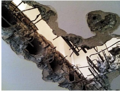
Obr. 17 Náhled na vybouranou strukturu železobetonu, který tvoří stropní panel [5].
