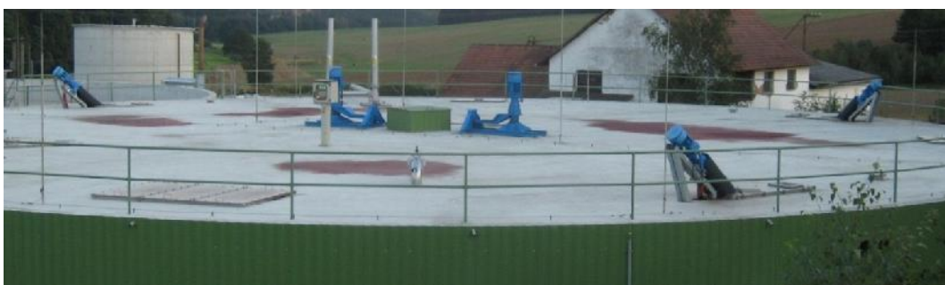
Obrázek 10 – Fermentor s míchadly
