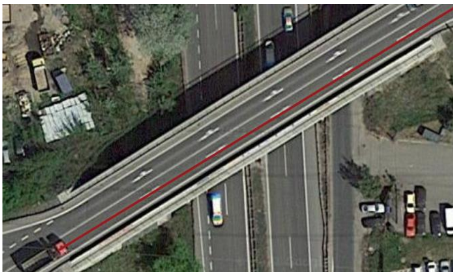
Obrázek 30: Průjezd po mostě nad silnicí číslo E461 Levotočivá zatáčka v areálu [2]
