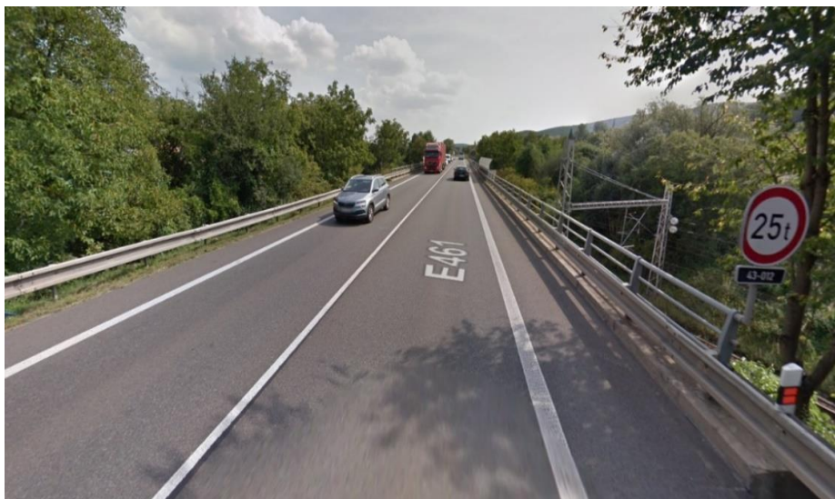
Obrázek 5: Mimoúrovňové křížení silnice E461 a kolejí [2]
