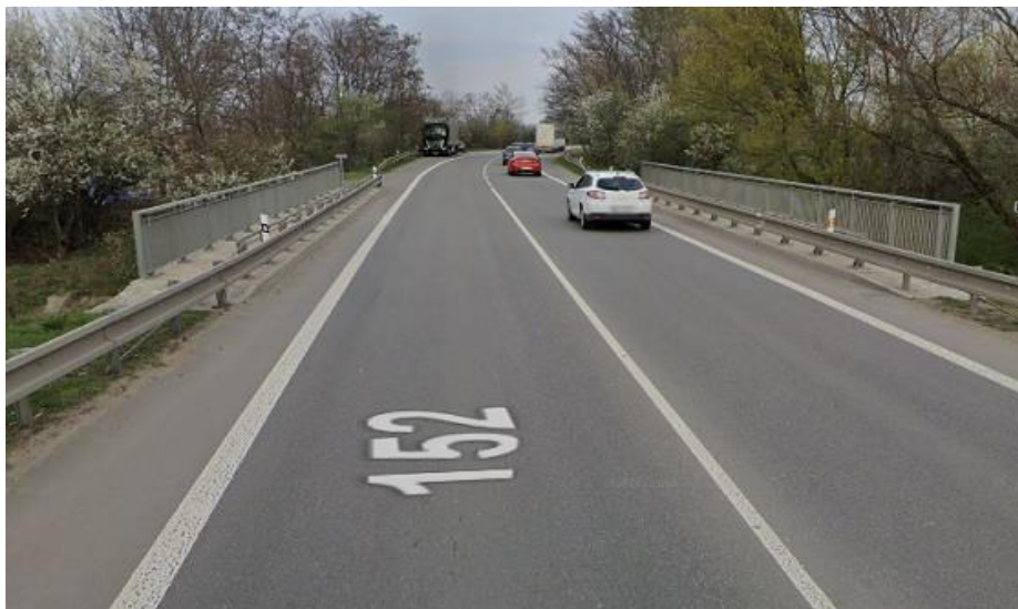
Obrázek 19: Přejezd po mostě přes řeku [2]
