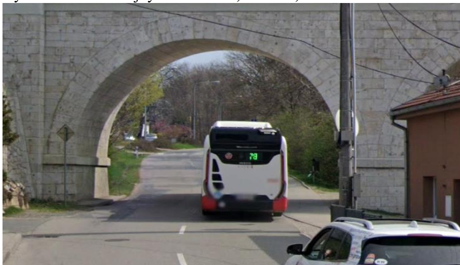
Obrázek 22: Železniční viadukt v Chrlicích [1]
