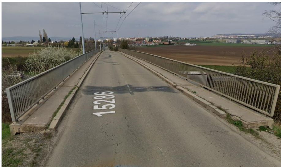
Obrázek 43: Přejezd přes most na silnici číslo 15286 [2]
