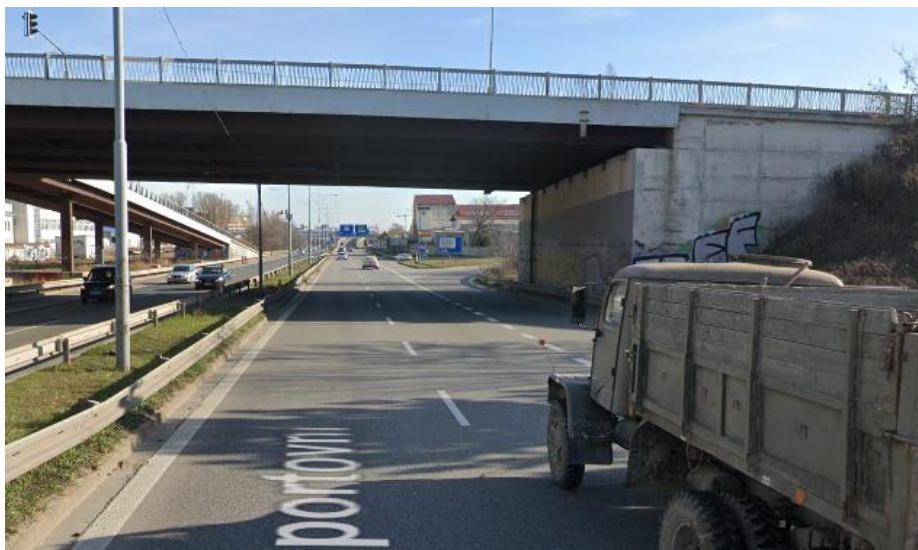
Obrázek 7: Podjezd pod ulicí Křížkova [2]
