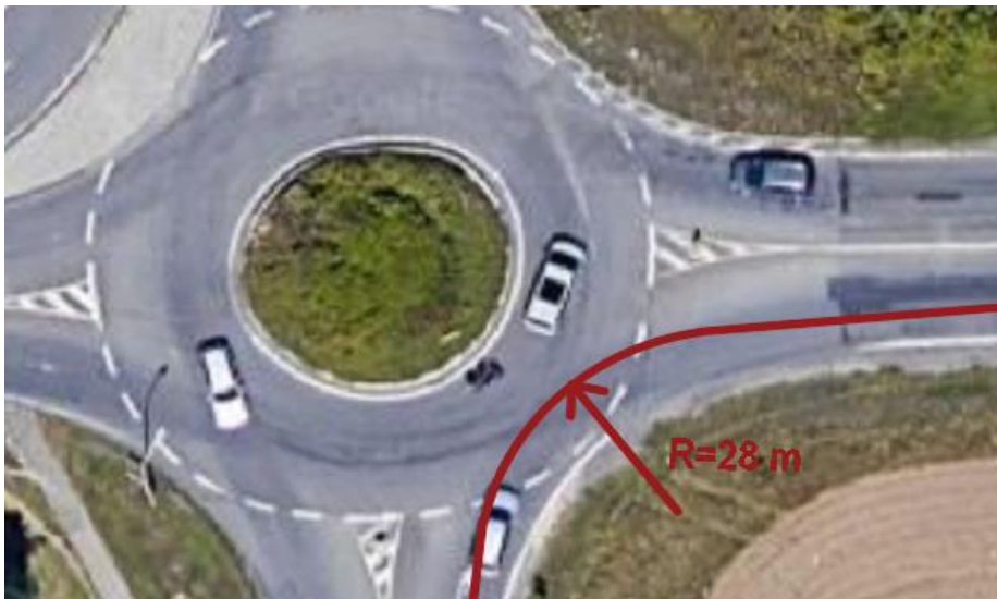
Obrázek 45: Přijezd z ulice Bedřichova, odbočení na silnici číslo 430 směr na Vyškov (upraveno autorem) [2]
