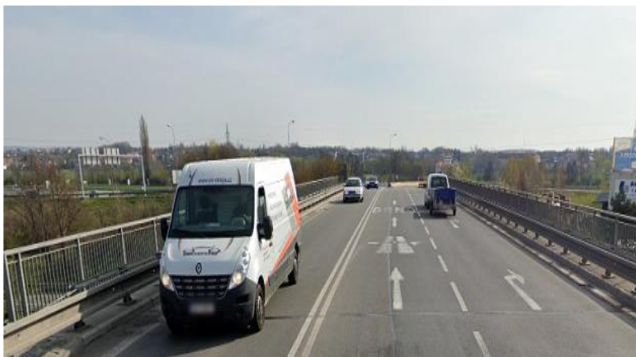
Obrázek 20: Přejezd mostu nad mezinárodní silnicí E65 [2]
