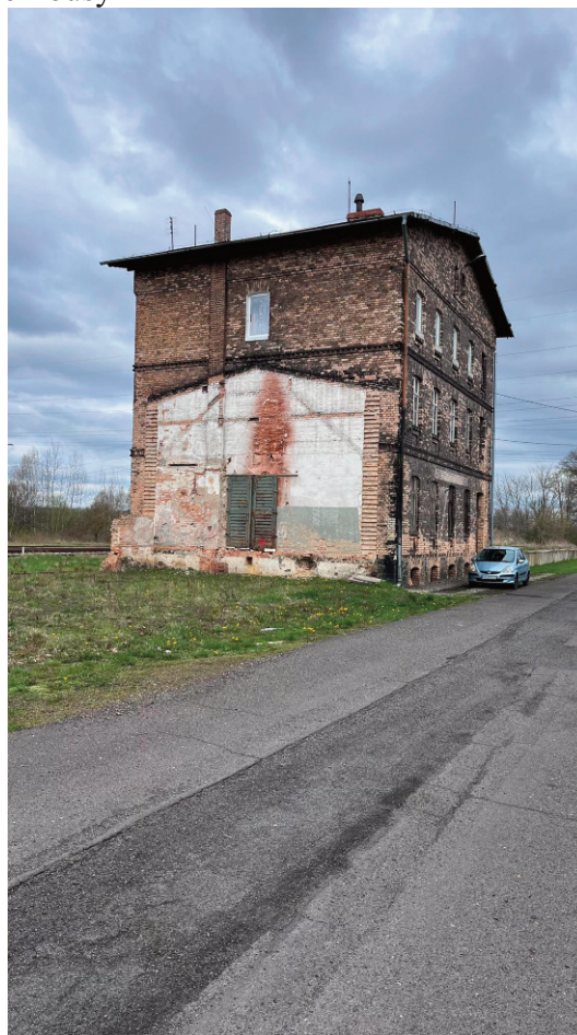
Obr. 6: Bývalá staniční budova Zawidów
