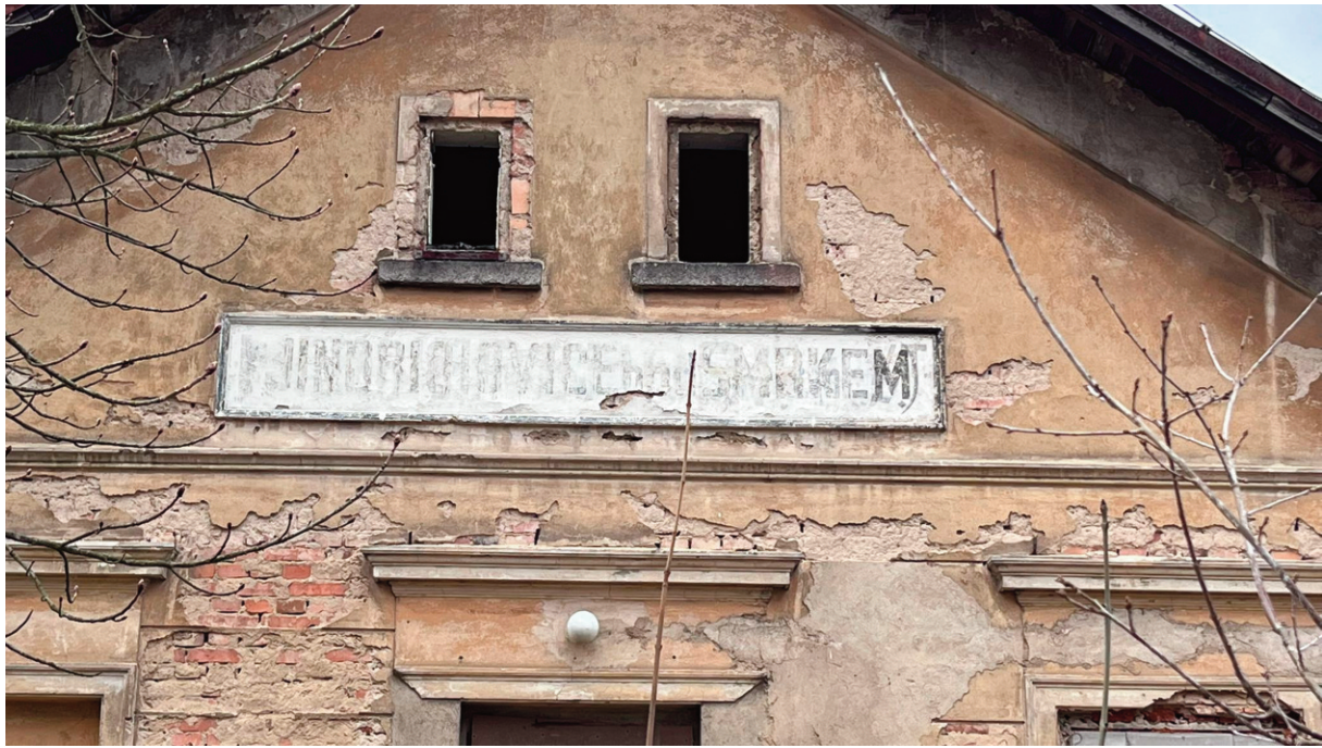
Obr. 18: Nápis na nádražní budově v Jindřichovicích p/S
