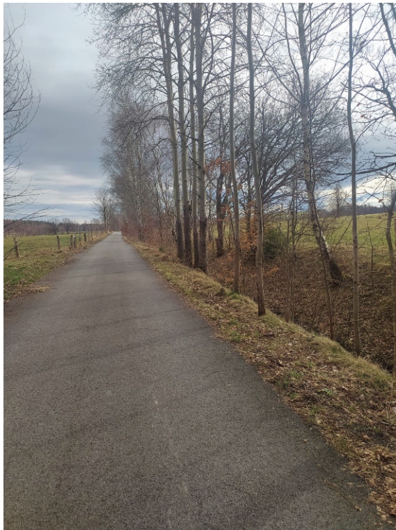
Obr. 19: Bývalé těleso tratě Jindřichovice - Mířsk
