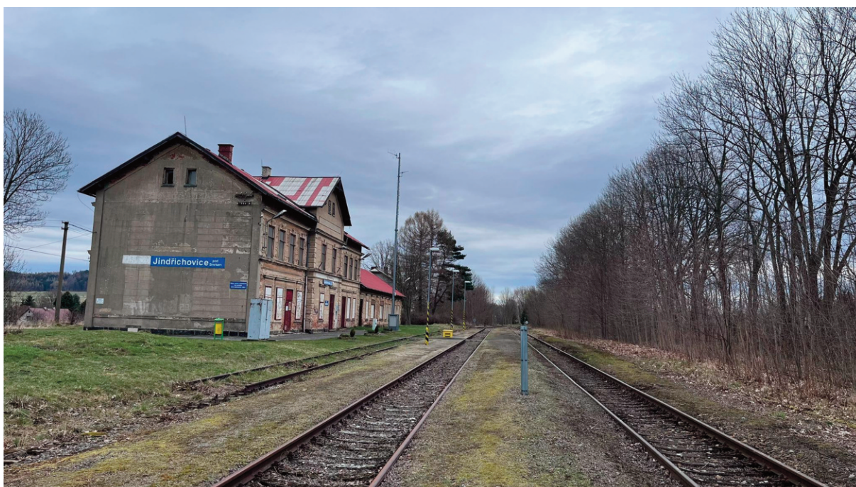
Obr. 26: Kolejištěs nádražní budovou v Jindřichovicích p/S
