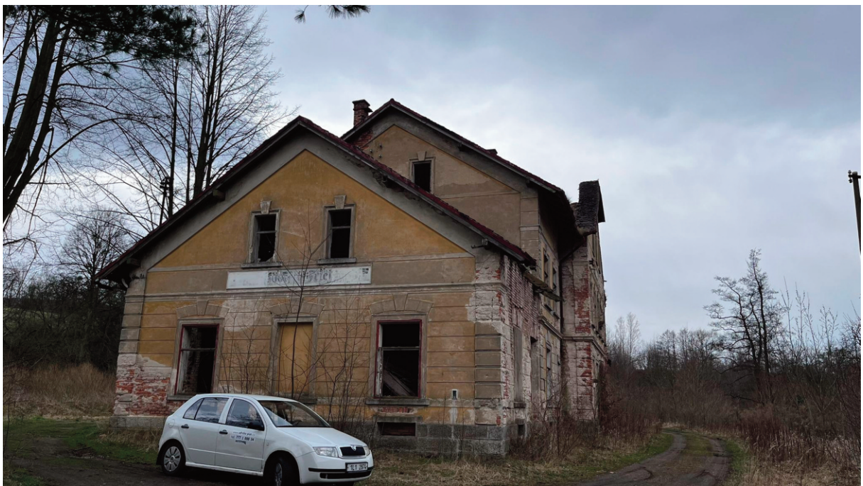
Obr. 17: Bývalá nádražní budova v Heřmanicích
