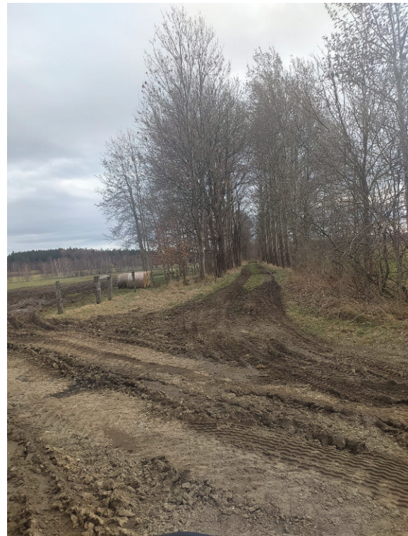
Obr. 20: Bývalé těleso tratě Jindřichovice - Mířsk
