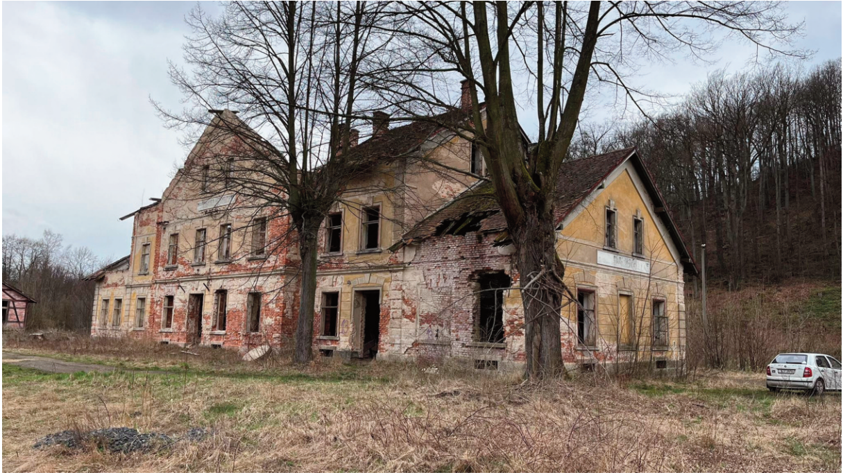
Obr. 16: Bývalá nádražní budova v Heřmanicích
